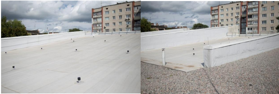
Рис. 8.1 – Капітальний покрівлі центру «Перемога»
