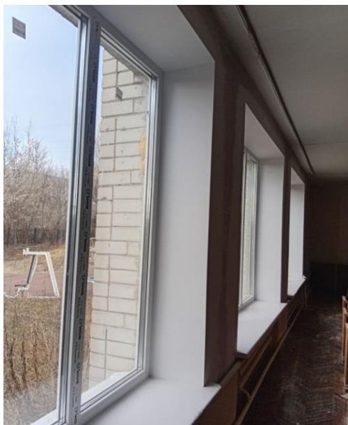
Рис. 8.6 – Металопластикові конструкції у Гуртожитку № 2
