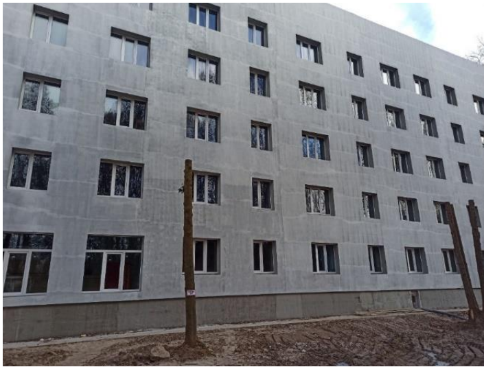
Рис. 8.5– Термо модернізація Гуртожитку №1
