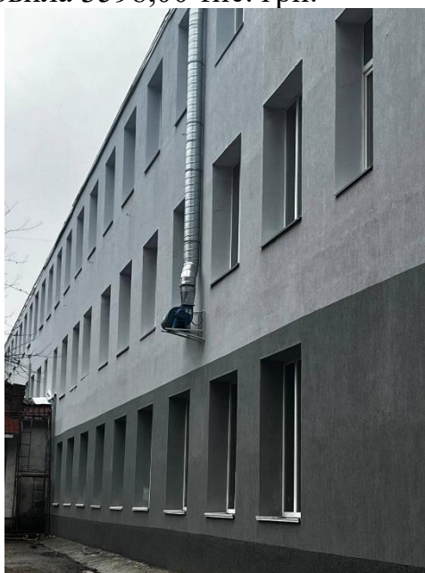
Рис. 8.12 – Утеплення фасаду навчального корпусу №2
