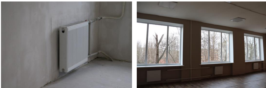
Рис. 8.5 – Відновлено систему опалення
