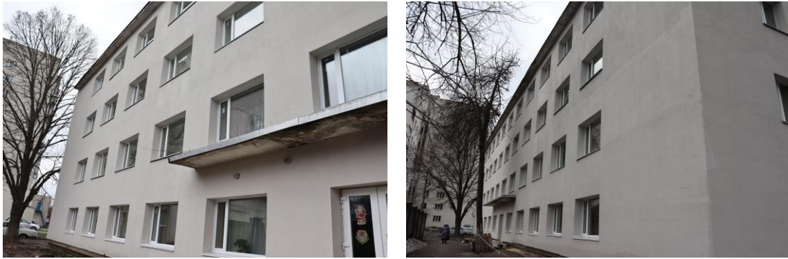
Рис 8.6 – Утеплення фасаду площею 958 м 2 будівлі гуртожитку №5
