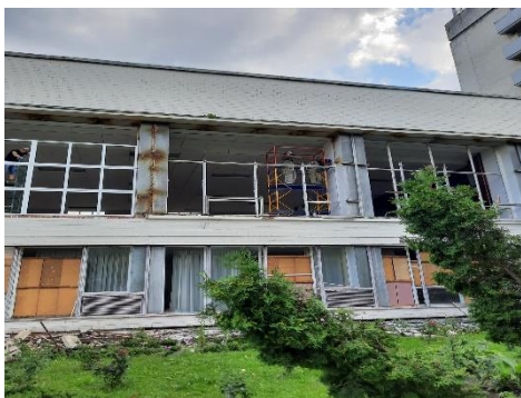
Рис. 7.7 – відновлення спортивної зали: часткова заміна перекриття даху, частковий ремонт підлоги, заміна системи опалення, вікон та дверей, проведено шпаклювання та фарбування стін, заміна освітлення
