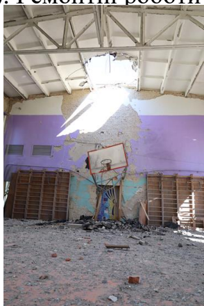
Рис. 7.7 – відновлення спортивної зали: часткова заміна перекриття даху, частковий ремонт підлоги, заміна системи опалення, вікон та дверей, проведено шпаклювання та фарбування стін, заміна освітлення
