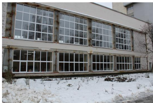
Рис. 7.7 – відновлення спортивної зали: часткова заміна перекриття даху, частковий ремонт підлоги, заміна системи опалення, вікон та дверей, проведено шпаклювання та фарбування стін, заміна освітлення
