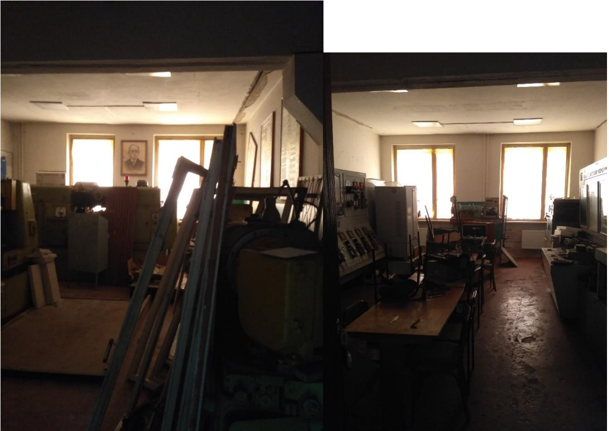
Фото 15-17. Вибиті дерев'яні вікна приміщень 104,108,109
