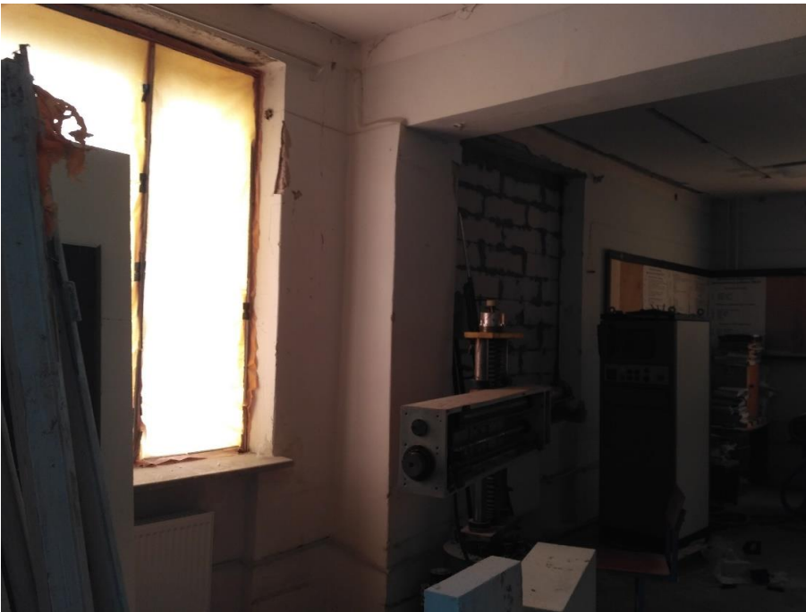
Фото 21. Вибиті дерев'яні вікна приміщення 208
