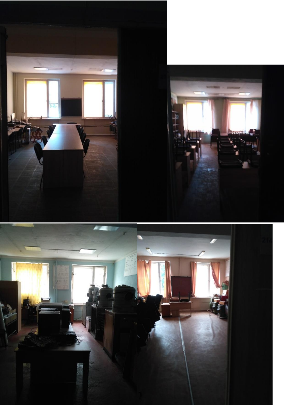
Фото 29-32. Вибиті дерев'яні вікна приміщення 214-217
