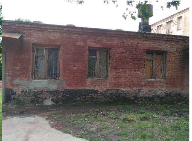
Фото 59-69. Пошкодження одноповерхової прибудови гаражів – пошкодження покрівлі, відшарування штукатурки стін та стелі, вибиті дерев'яні вікна
