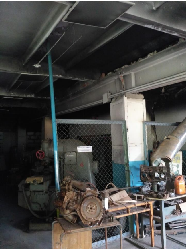
Фото 12-14. Пошкодження авіабомбою приміщення 105
