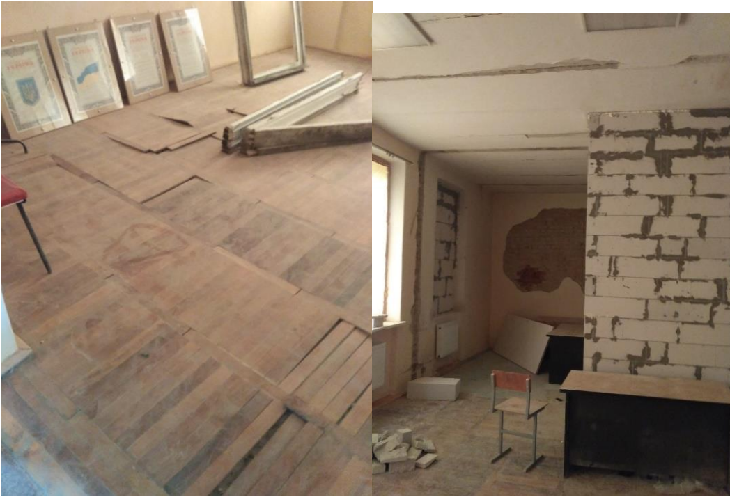
Фото 31-33. Вибиті дерев'яні вікна приміщення 205. Пошкодження паркету
