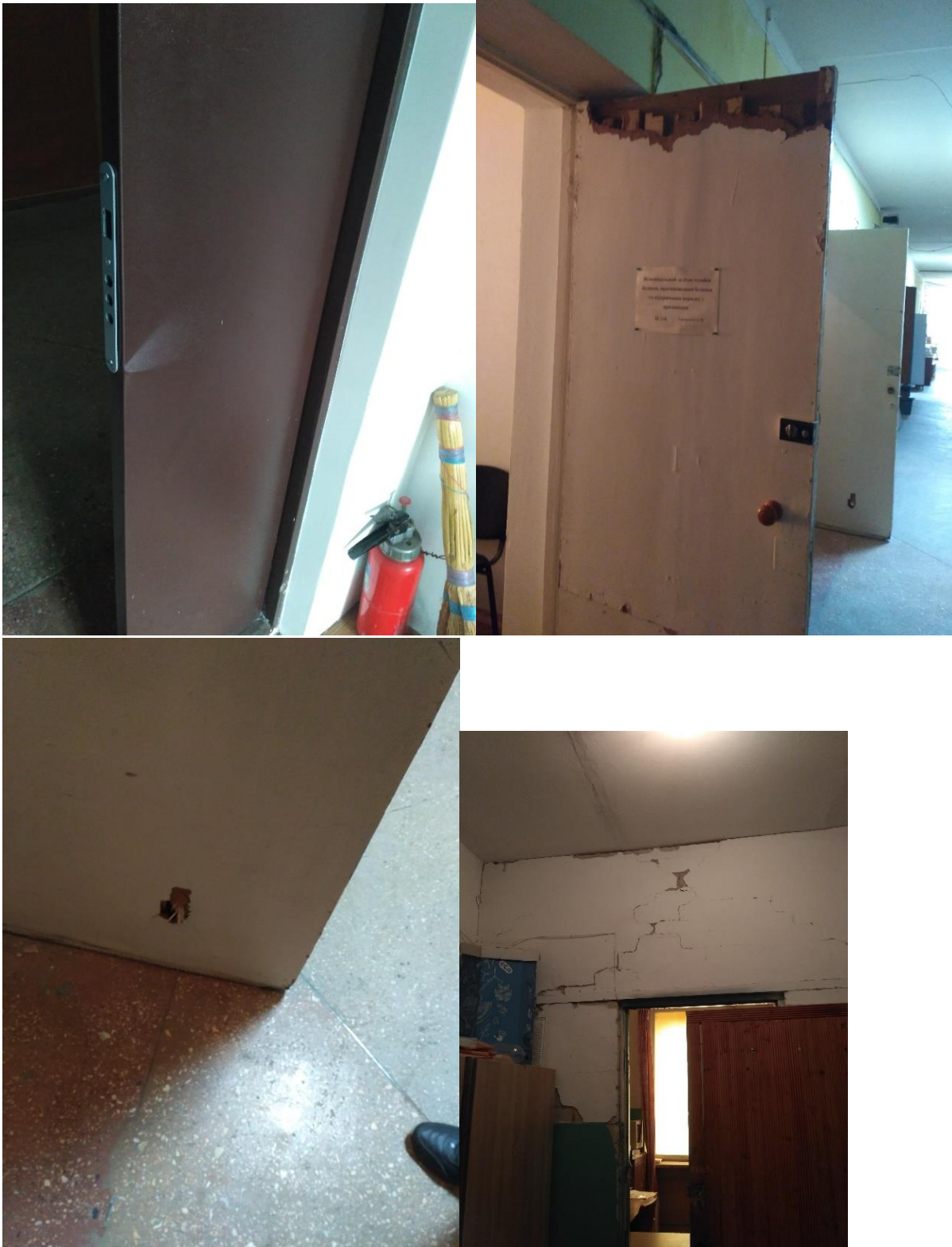
Фото 26-28. Пошкоджені двері приміщення 222-229
