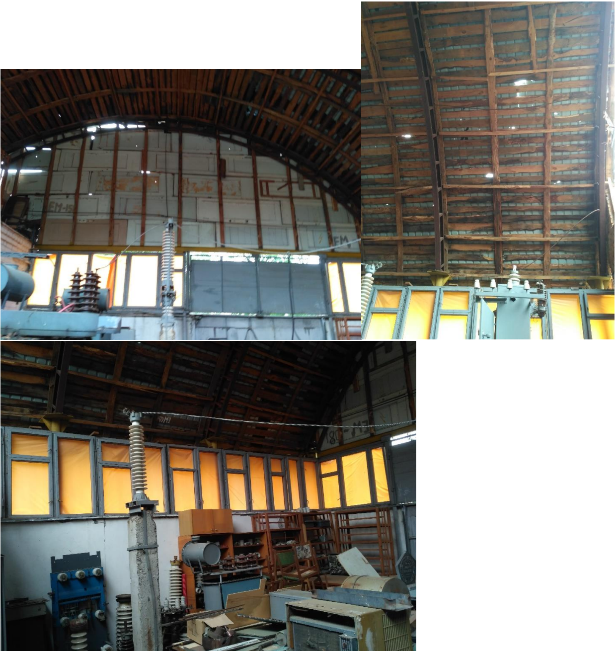
Фото 1,2,3 Пошкодження приміщення 108. Розбиті дерев'яні вікна, пошкоджена покрівля з профлиста, вибиті фронтони
