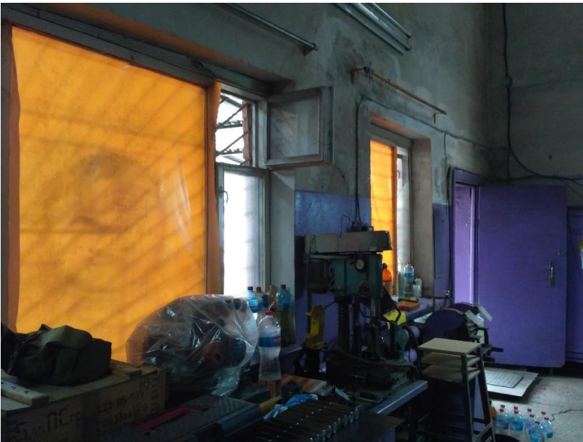
Фото 23. Вибиті дерев'яні вікна приміщення 101
