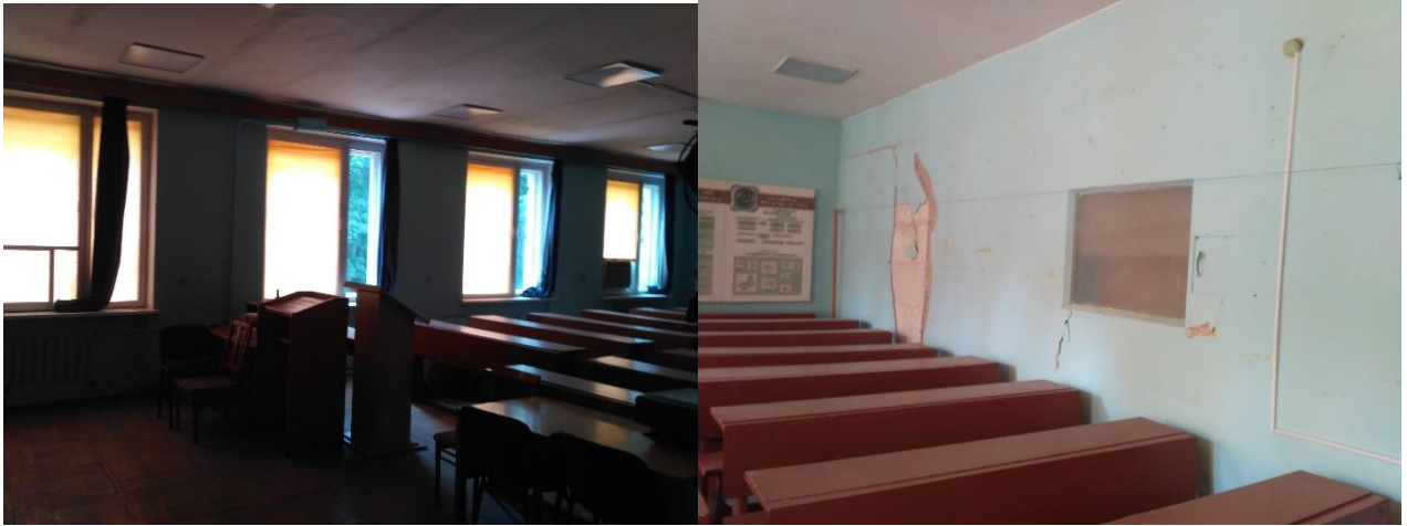
Фото 42-43. Вибиті дерев'яні вікна приміщення 308. Тріщини в штукатурці
