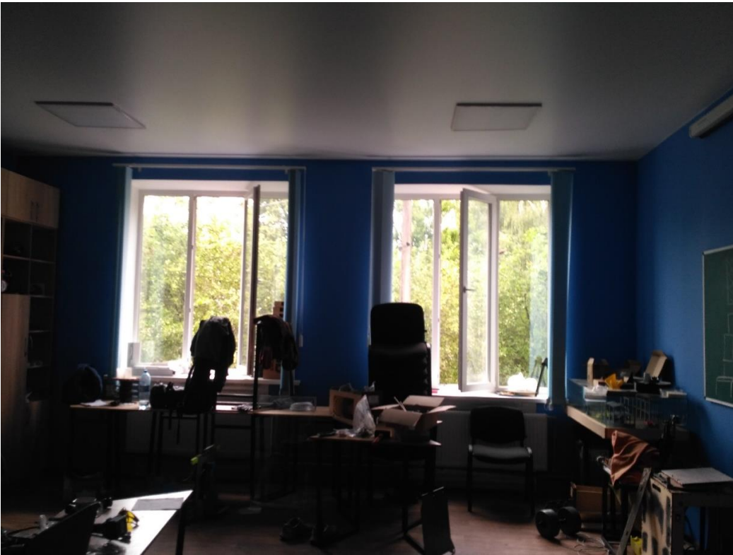
Фото 21-25. Вибиті дерев'яні вікна приміщення 220-222
