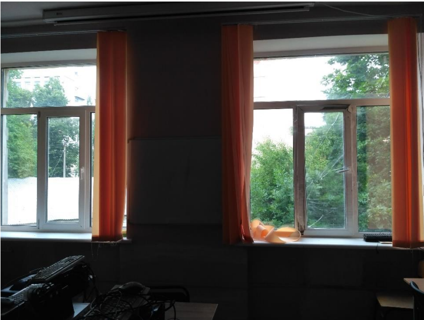
Фото 30. Вибиті дерев'яні вікна приміщення 204
