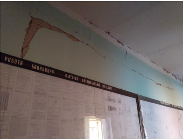
Фото 39. Тріщини штукатурки в коридорі 301
