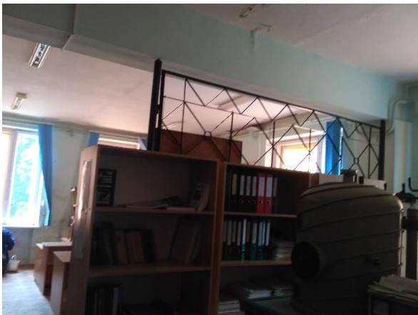
Фото 46. Вибиті дерев'яні вікна приміщення 314
