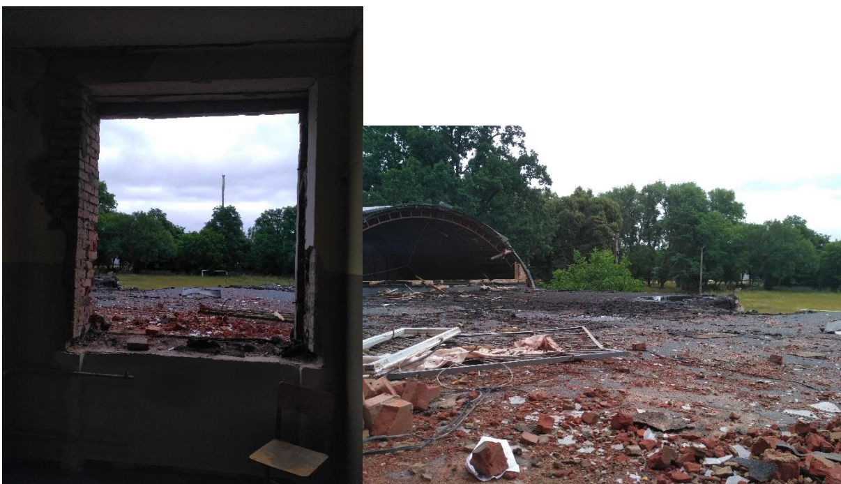
Фото 22-23. Вибите дерев'яне вікно коридору 201. Пошкоджена покрівля одноповерхової прибудови
