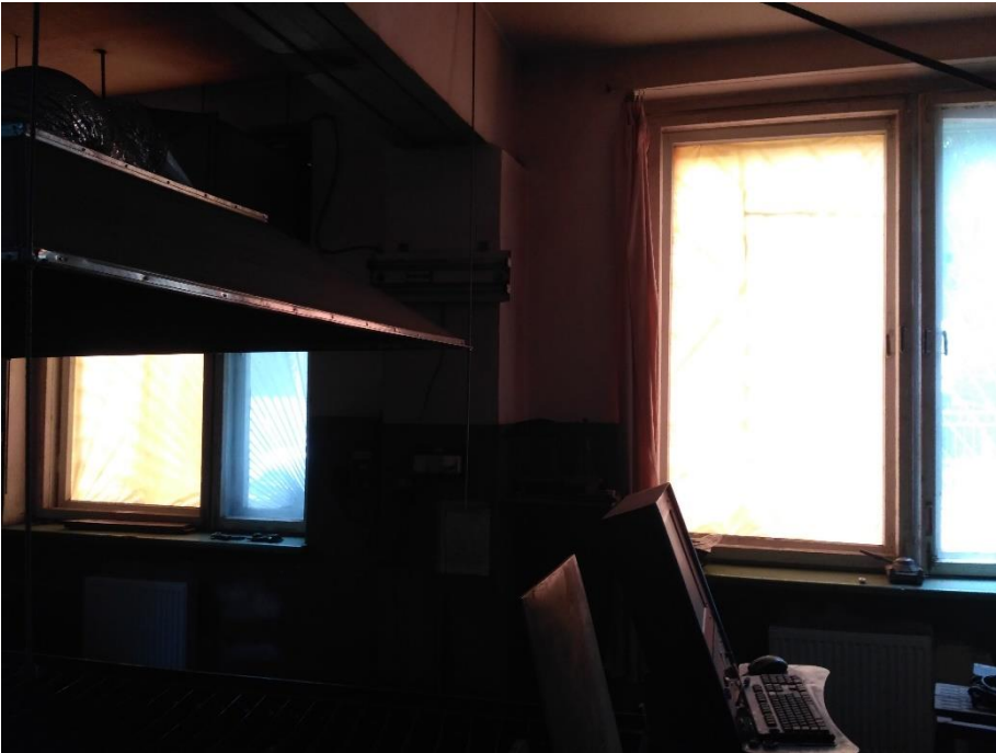
Фото 21-22. Вибиті дерев'яні вікна приміщення 118,119
