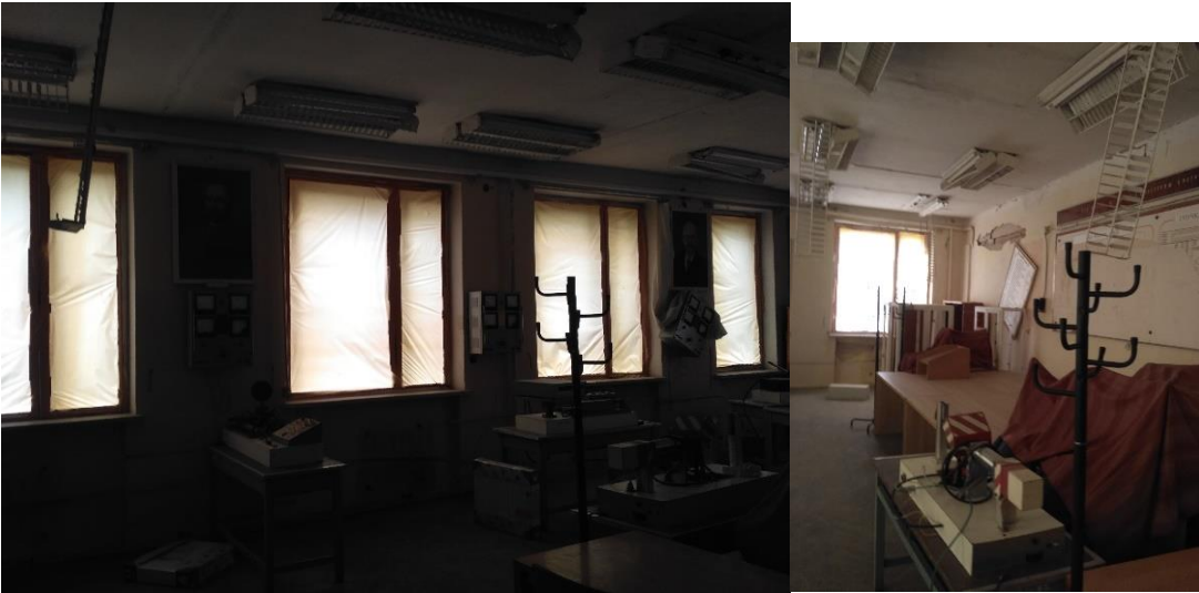
Фото 38. Вибиті дерев'яні вікна приміщення 303
