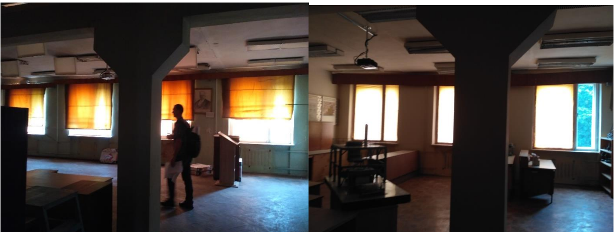
Фото 40-41. Вибиті дерев'яні вікна приміщення 306-307
