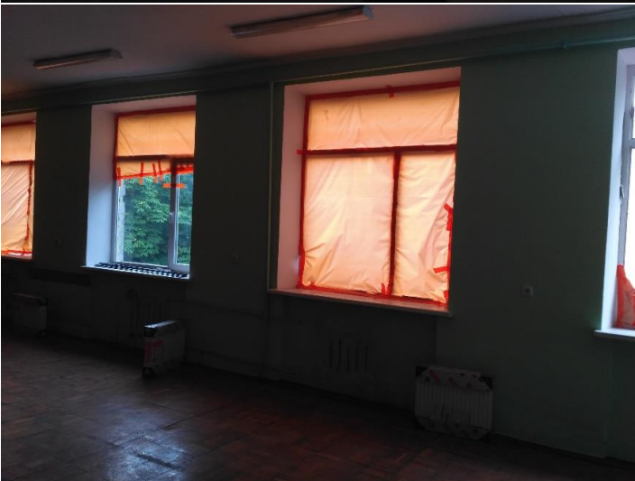
Фото 57-58. Вибиті дерев'яні вікна приміщення 302-303
