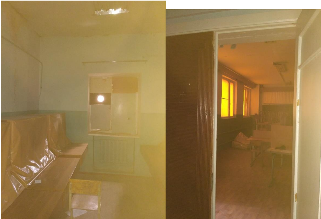
Фото 4-6. Пошкодження приміщень 102-104. Вибиті зовнішні двері, дерев'яні вікна
