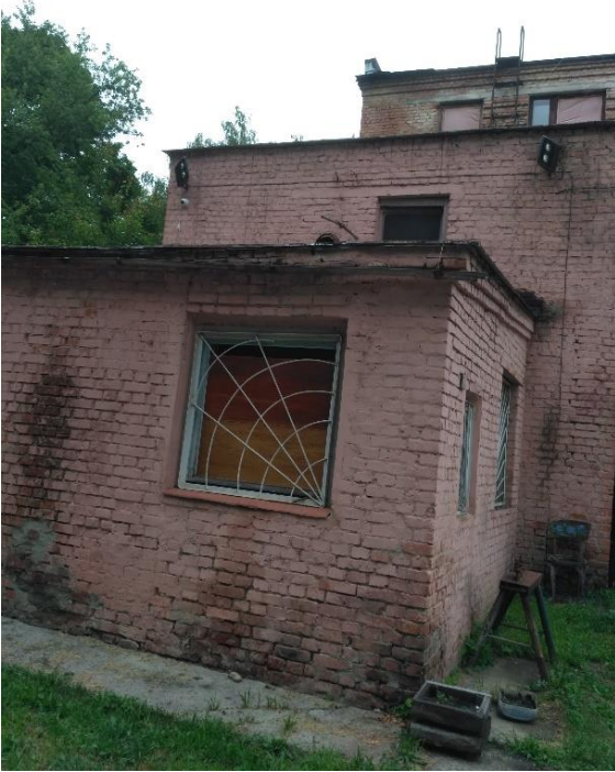
Фото 24. Вибиті дерев'яні вікна приміщення 6-101,7-101
