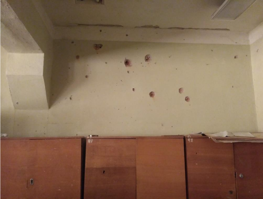
Фото34-37. приміщення 305. Вибиті дерев'яні вікна. Осколкове ураження стін. Вибиті двері
