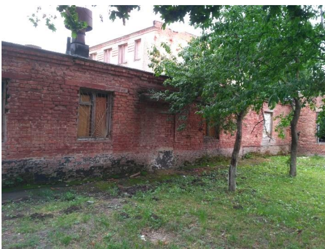
Фото 59-69. Пошкодження одноповерхової прибудови гаражів – пошкодження покрівлі, відшарування штукатурки стін та стелі, вибиті дерев'яні вікна
