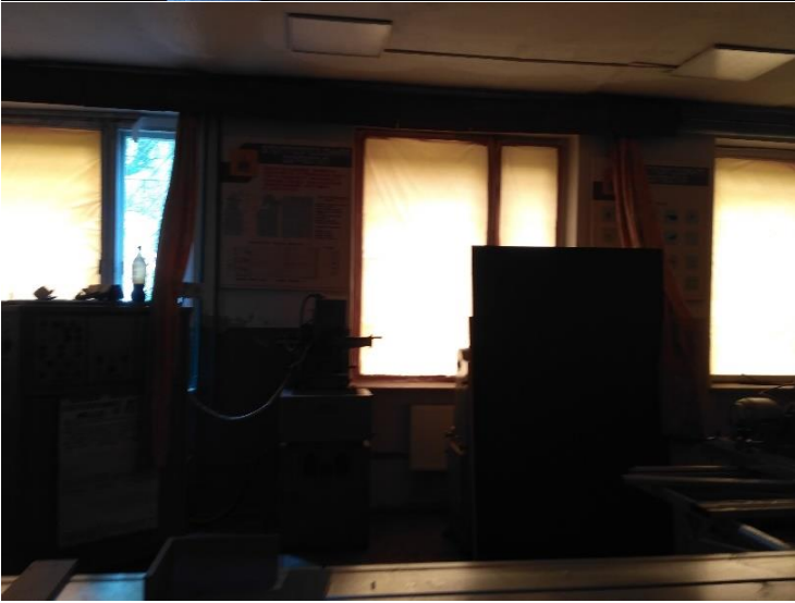
Фото 26-28. Вибиті дерев'яні вікна приміщення 123-125
