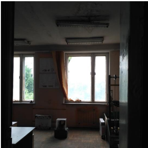
Фото 51. Вибиті дерев'яні вікна приміщення 319
