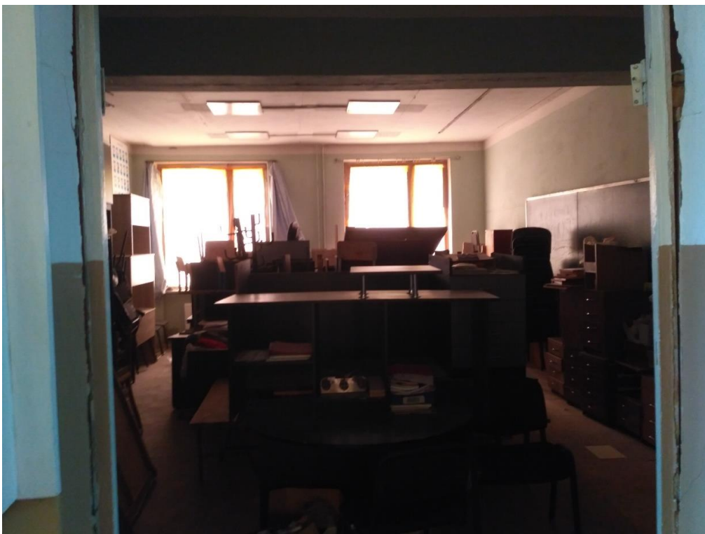
Фото 24. Вибиті дерев'яні вікна приміщення 209
