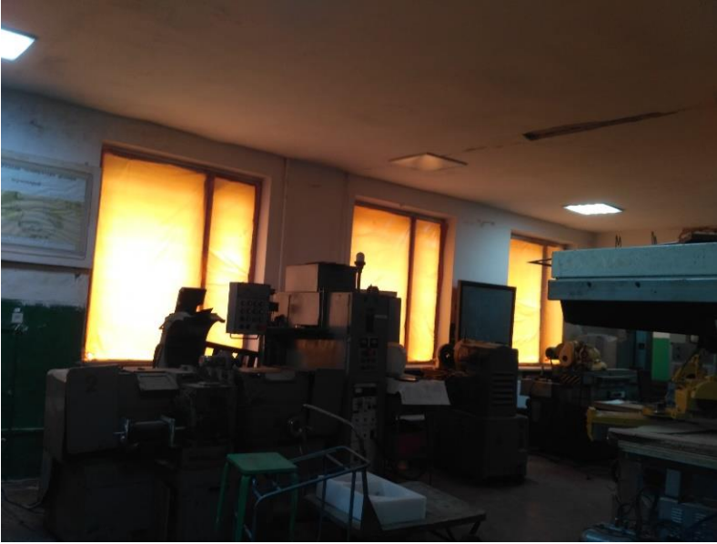
Фото 20. Вибиті дерев'яні вікна приміщення 103
