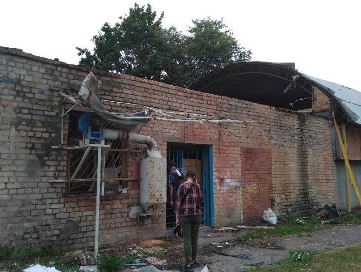
Фото 9-11. Пошкодження авіабомбою приміщень 101-102
