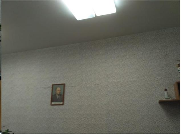
Фото 98-101 Пошкоджені дерев'яні вікна прим. 211,212,213. Горизонтальна тріщина в штукатурці прим 213 шир. 2мм
