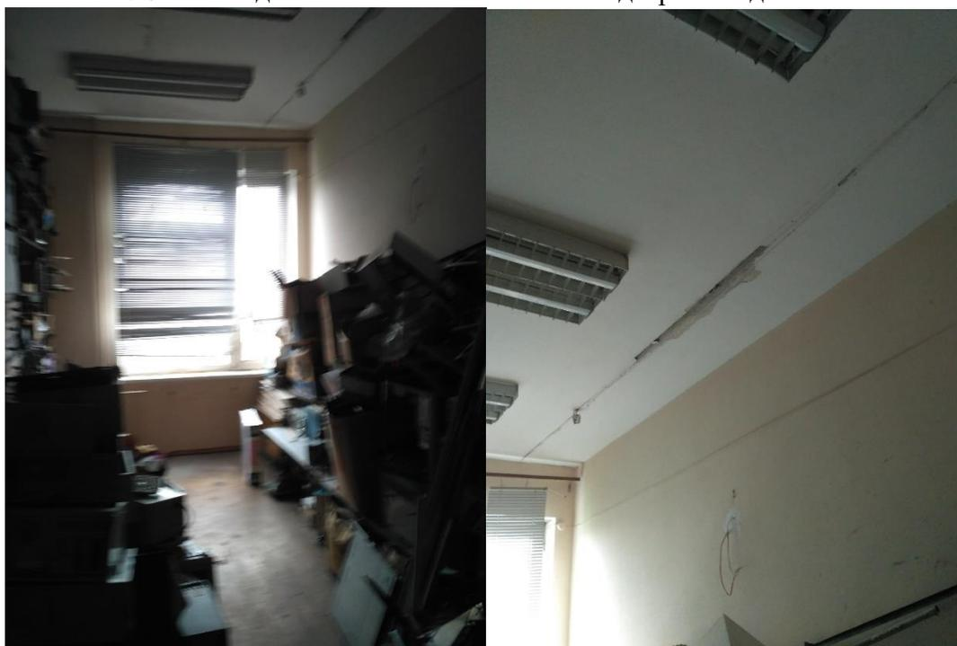
Фото 10-11 Пошкодження дерев'яного вікна прим. 915. Відшарування стелі
