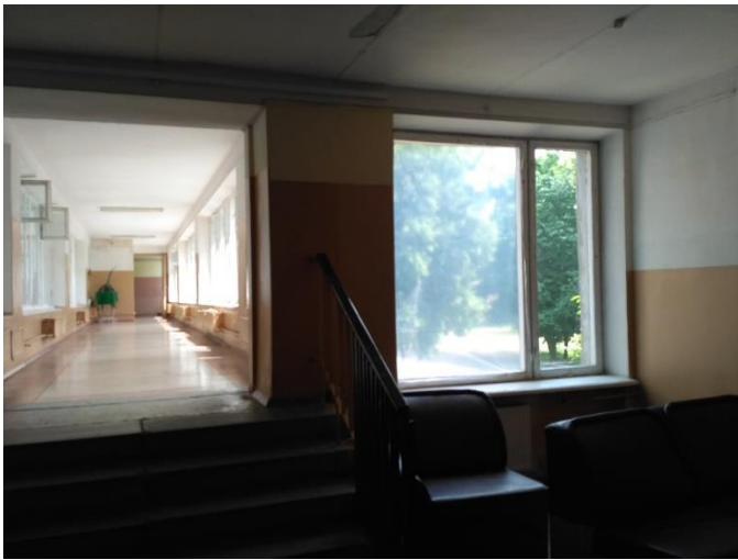
Фото 24 Пошкоджені дерев'яні вікна приміщення 220
