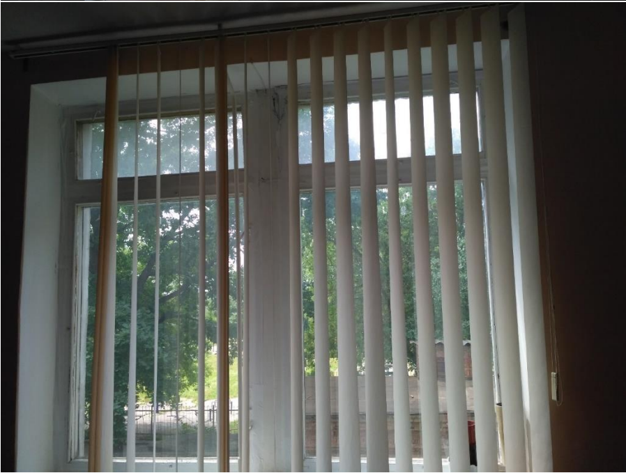
Фото 37-39 Пошкоджені дерев'яні вікна приміщень 202-205
