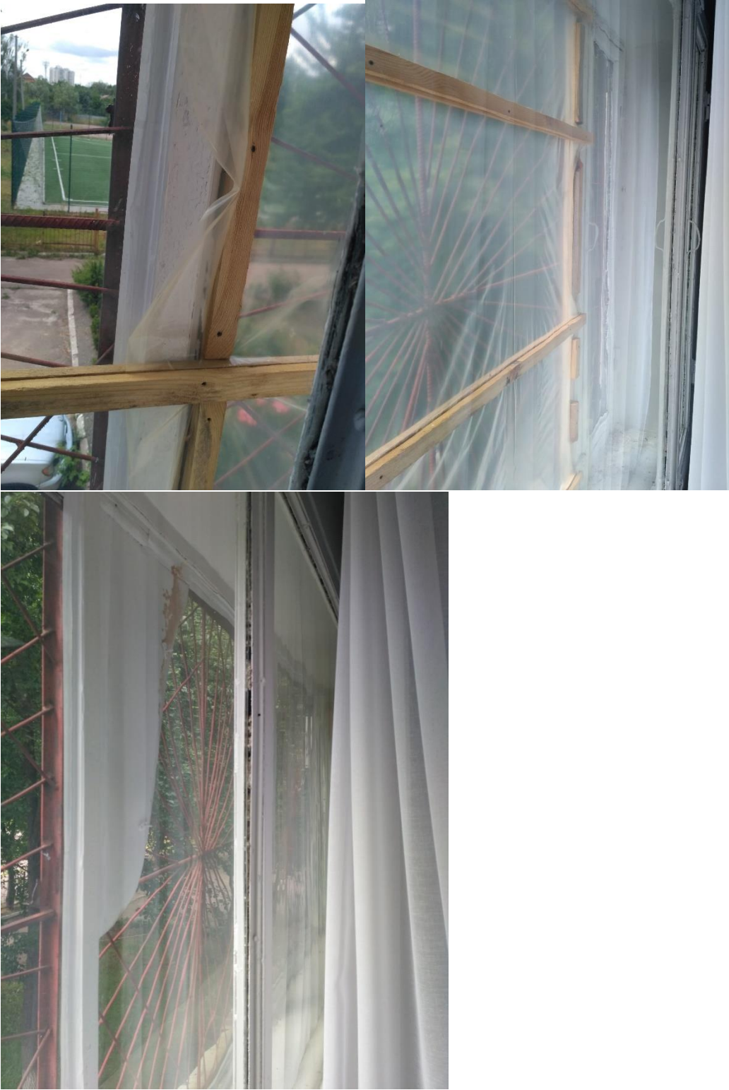
Фото 44-46 Пошкоджені дерев'яні вікна приміщення 227
