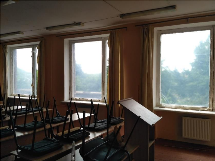
Фото 67-69 Пошкоджені дерев'яні вікна приміщень 321-232
