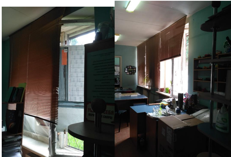
Фото 13,14 Пошкоджені дерев'яні вікна приміщень 109-110
