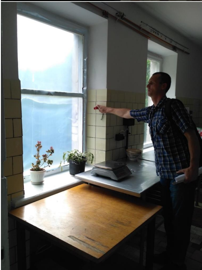
Фото 47-48 Пошкоджені дерев'яні вікна приміщень 229,236
