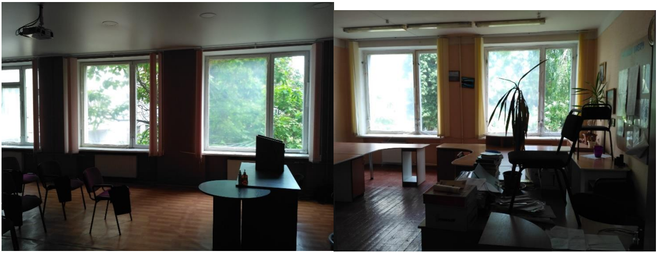
Фото 28,29 Пошкоджені дерев'яні вікна приміщень 222,224
