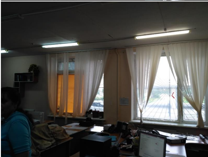
Фото 6-10 Пошкоджені дерев'яні вікна приміщень 119-116
