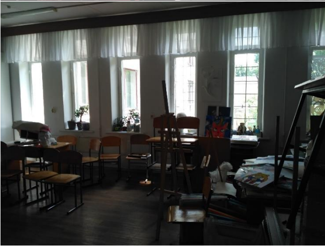
Фото 19,21 Пошкоджені дерев'яні вікна приміщень 214-212
