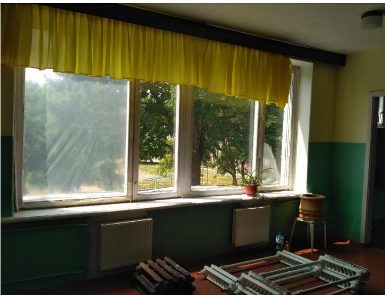
Фото 36 Пошкоджене дерев'яне вікно приміщення 201
