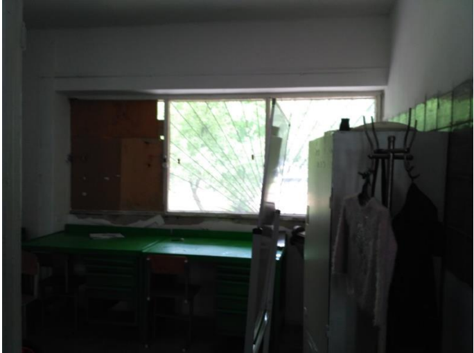
Фото 11,12 Пошкоджені дерев'яні вікна приміщень 111-112
