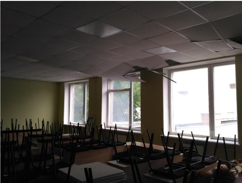
Фото 63,64 Пошкоджені дерев'яні вікна приміщення 319. Зруйновано стелю армстронг
