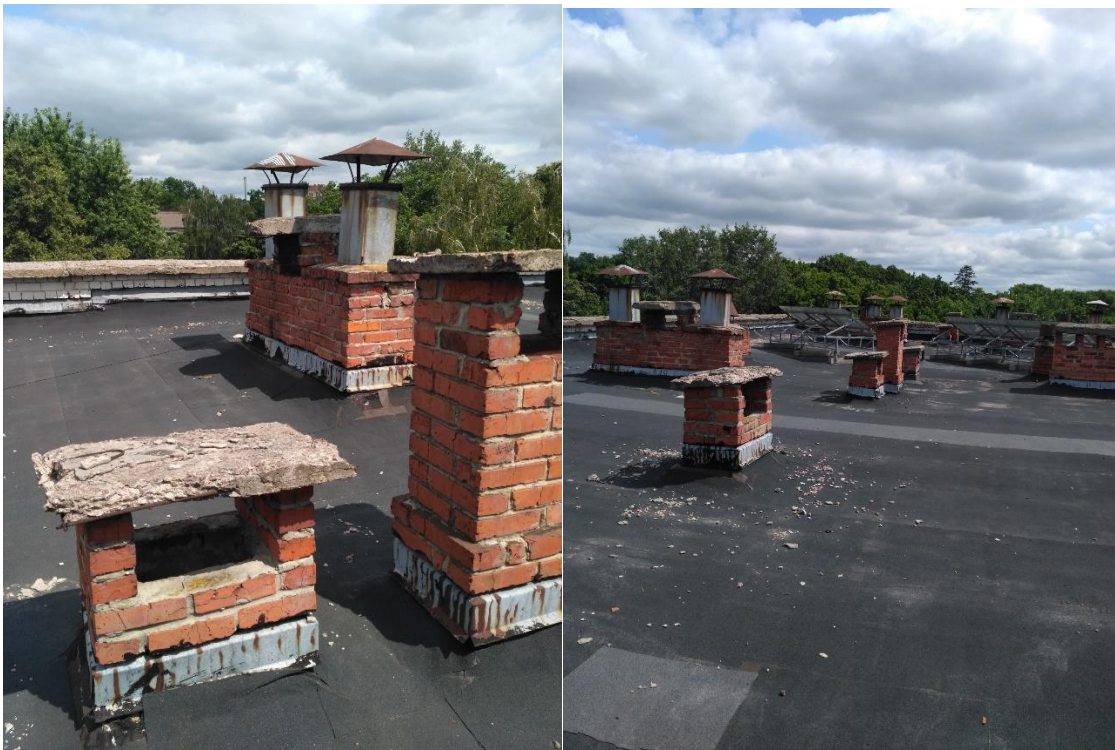
Фото 80-83 Стан покрівлі. Покрівля з рубероїду в нормальному стані, пошкоджень осколками немає. Внаслідок атмосферних впливів пошкоджено з/б парпетні плити та дашки вентиляхт
