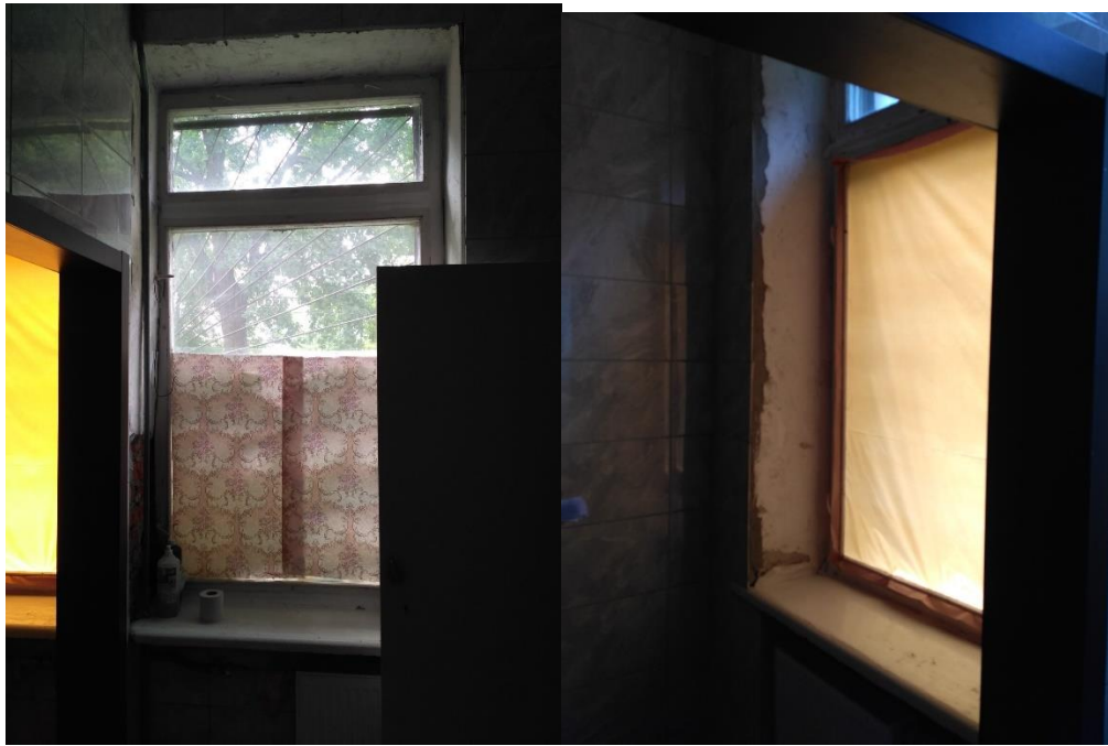
Фото 17,18 Пошкоджене дерев'яне вікно приміщення 103,104
