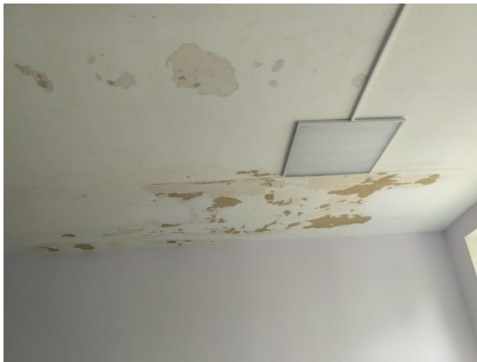
Фото 25,26 Цілі м.п вікна приміщень 219. Відшарування шпаклівки стелі
