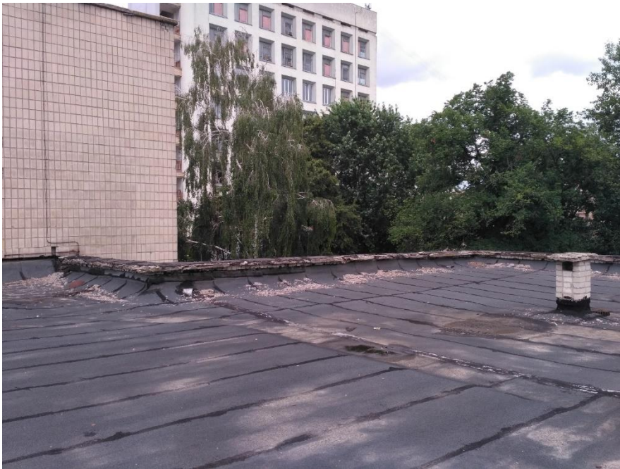
Фото 50-54 Стан покрівлі. Покрівля в нормальному стані. Слідів пошкодження руберойду осколками немає. Внаслідок атмосферних впливів протягом десятиліть пошкоджено парапетні плити та дашки вентшахт
