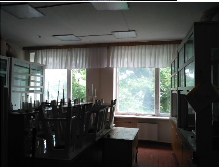
Фото 61-62 Пошкоджені дерев'яні вікна приміщень 315,316,317,318
