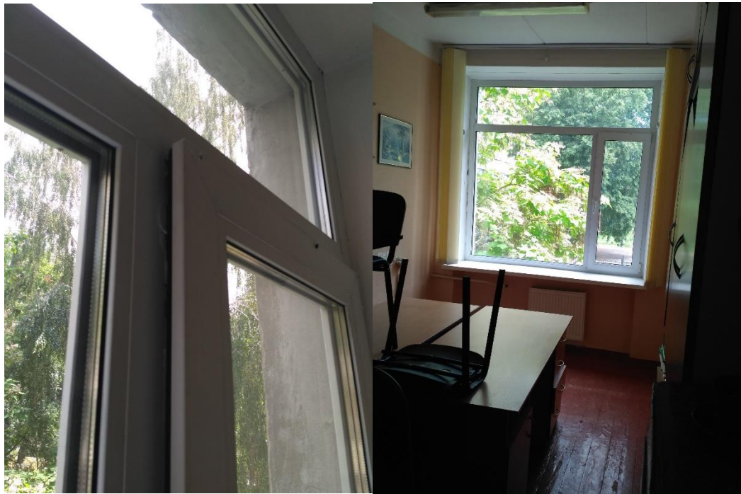
Фото 30,31 Пошкоджене м.п вікно приміщення 223. Тріснутий профіль рами
