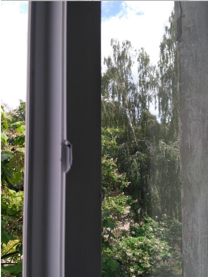
Фото 65,66 Пошкоджене м.п вікно приміщення 320. Два вікна цілі
