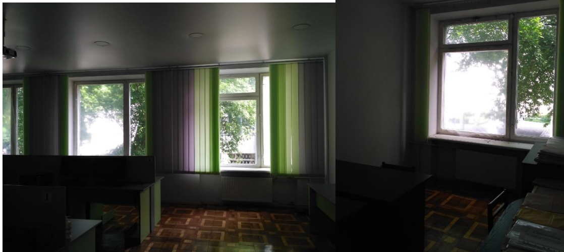
Фото 22,23 Пошкоджені дерев'яні вікна приміщень 217,218
