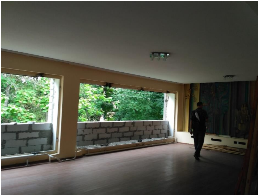
Фото 49 Пошкоджені та демонтовані дерев'яні вікна приміщення 228
