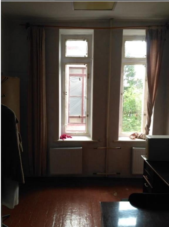
Фото 55-59 Пошкоджені дерев'яні вікна приміщень 311,313,314. Відлущення шпаклівки стелі
