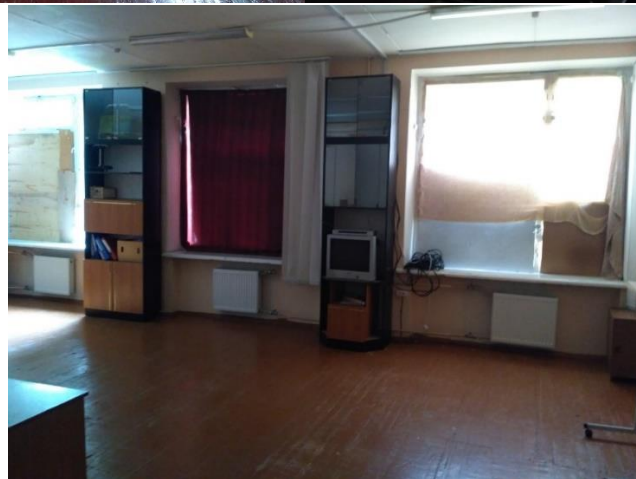
Фото 3-5 Пошкоджені дерев'яні вікна приміщень 123-121
