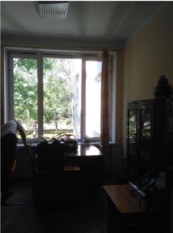
Фото 20. Пошкодження приміщення 212. Пошкодження м.п вікна( розбитий склопакет, пошкодження фурнітури, рам).
