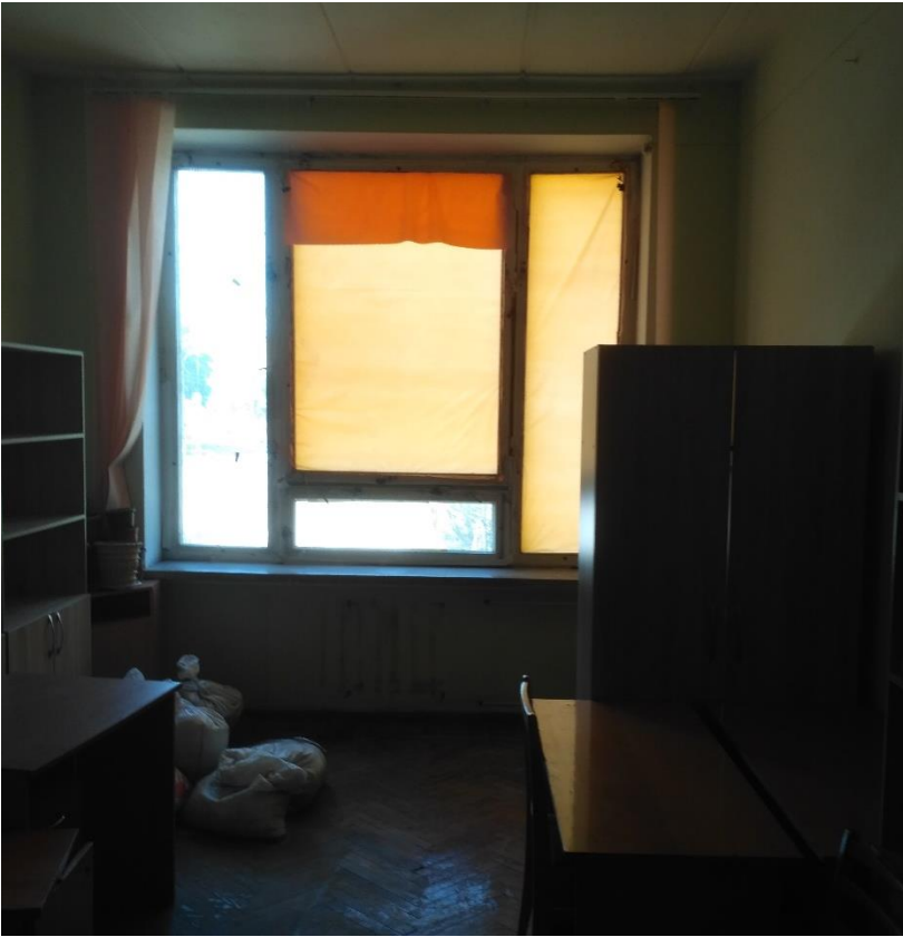
Фото 11. Пошкодження приміщення 206. Пошкодження дерев'яного вікна( розбите скло, пошкодження фурнітури, рам).
