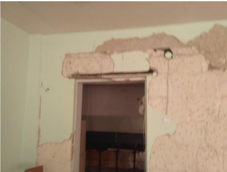
Фото 34-37. Пошкодження приміщення 231. Пошкоджені дерев'яні вікна( розбите скло, пошкодження фурнітури, рам). Тріщини та пошкодження мурування перегородок та її штукатурки
