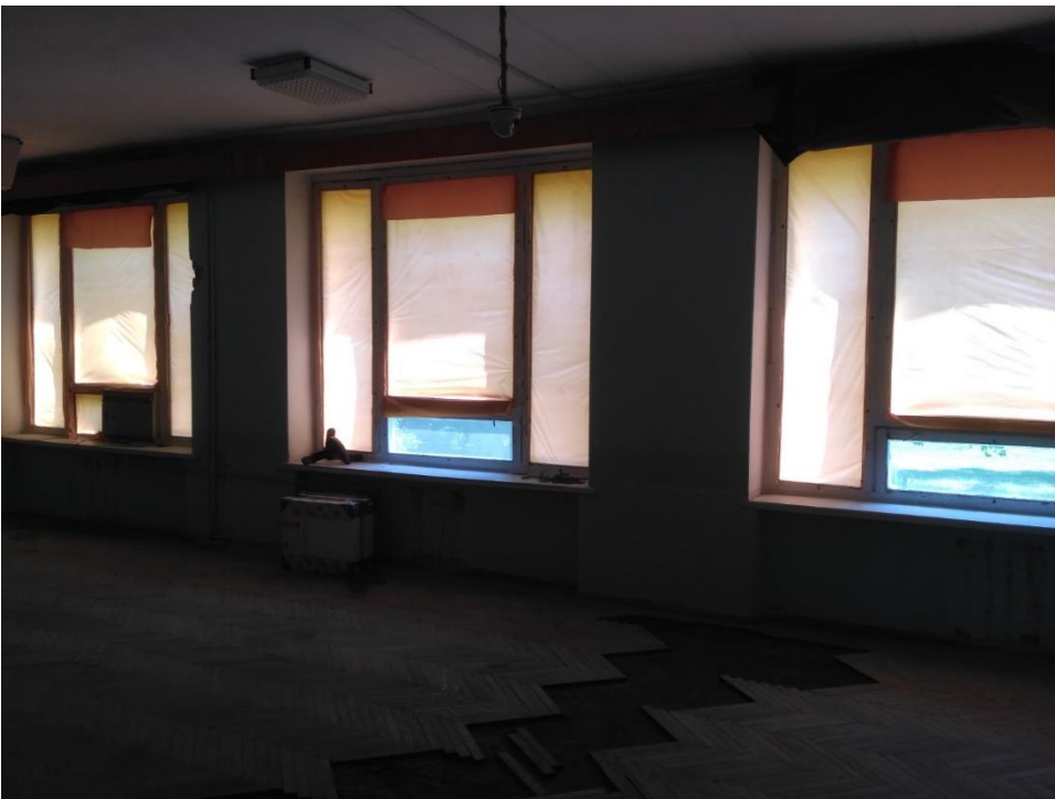
Фото 41. Пошкодження приміщення 234. Пошкоджено дерев'яні вікна( розбите скло, пошкодження фурнітури, рам). Пошкоджений паркет
