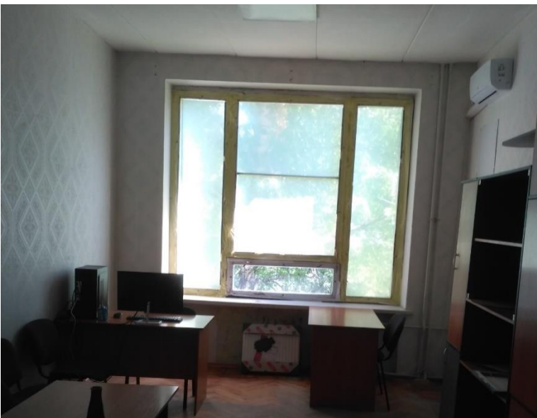
Фото 39. Пошкодження приміщення 232. Пошкоджено дерев'яне вікно( розбите скло, пошкодження фурнітури, рам).
