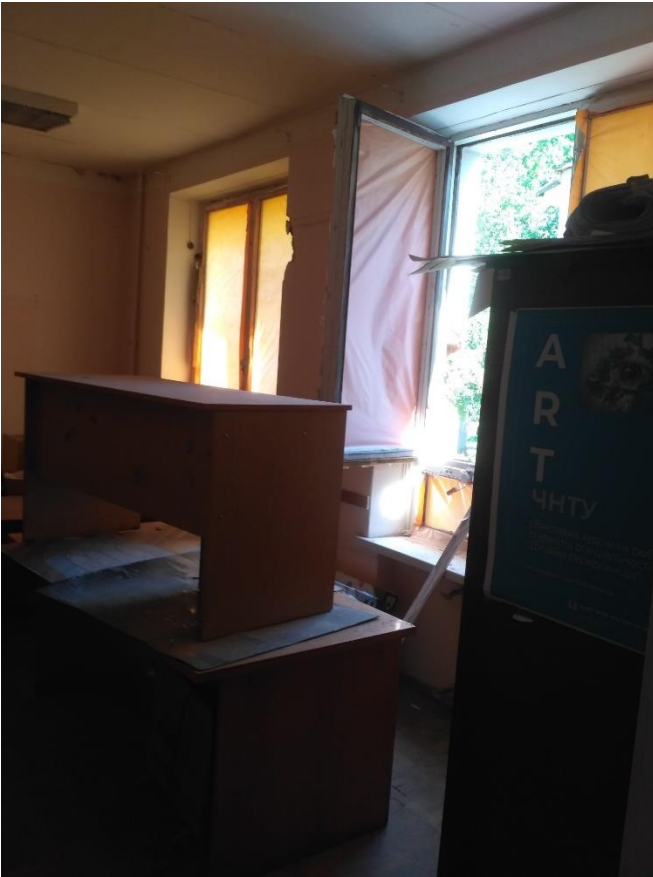
Фото 28. Пошкодження приміщення 217. Пошкоджені дерев'яні вікна( розбите скло, пошкодження фурнітури, рам).
