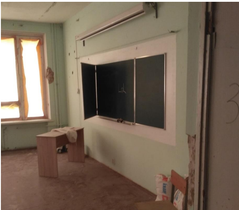
Фото 32-33. Пошкодження приміщення 229,230. Пошкоджені дерев'яні вікна( розбите скло, пошкодження фурнітури, рам). Тріщини та пошкодження штукатурки стін та стелі
