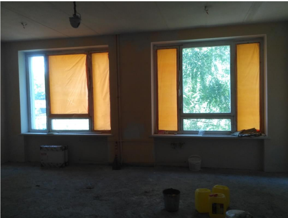
Фото 14,15. Пошкодження приміщення 208. Пошкодження дерев'яних вікон( розбите скло, пошкодження фурнітури, рам). Двері вибиті
