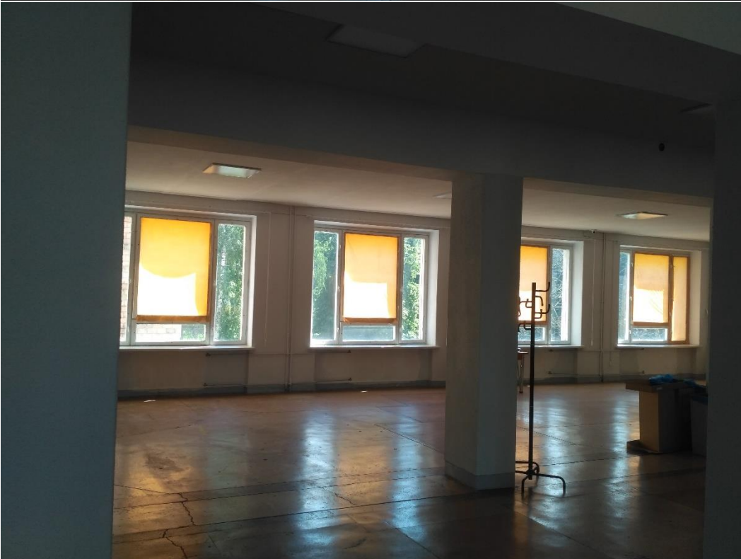
Фото 1,2. Пошкодження приміщення 273. Пошкодження дерев'яних вікон( розбите скло, пошкодження фурнітури, рам).
