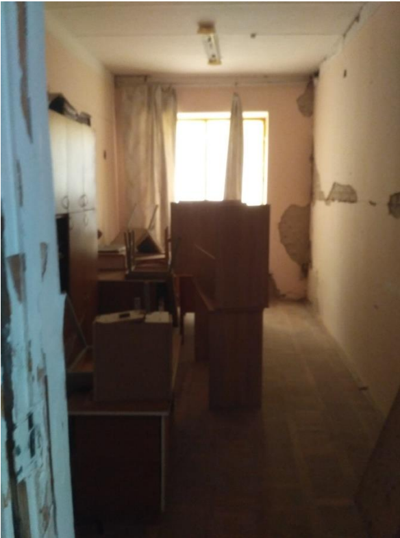
Фото 25-27. Пошкодження приміщення 215а,216. Пошкоджені дерев'яні вікна( розбите скло, пошкодження фурнітури, рам). Тріщини та пошкодження штукатурки
