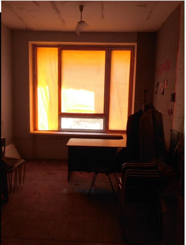
Фото 32-33. Пошкодження приміщення 229,230. Пошкоджені дерев'яні вікна( розбите скло, пошкодження фурнітури, рам). Тріщини та пошкодження штукатурки стін та стелі
