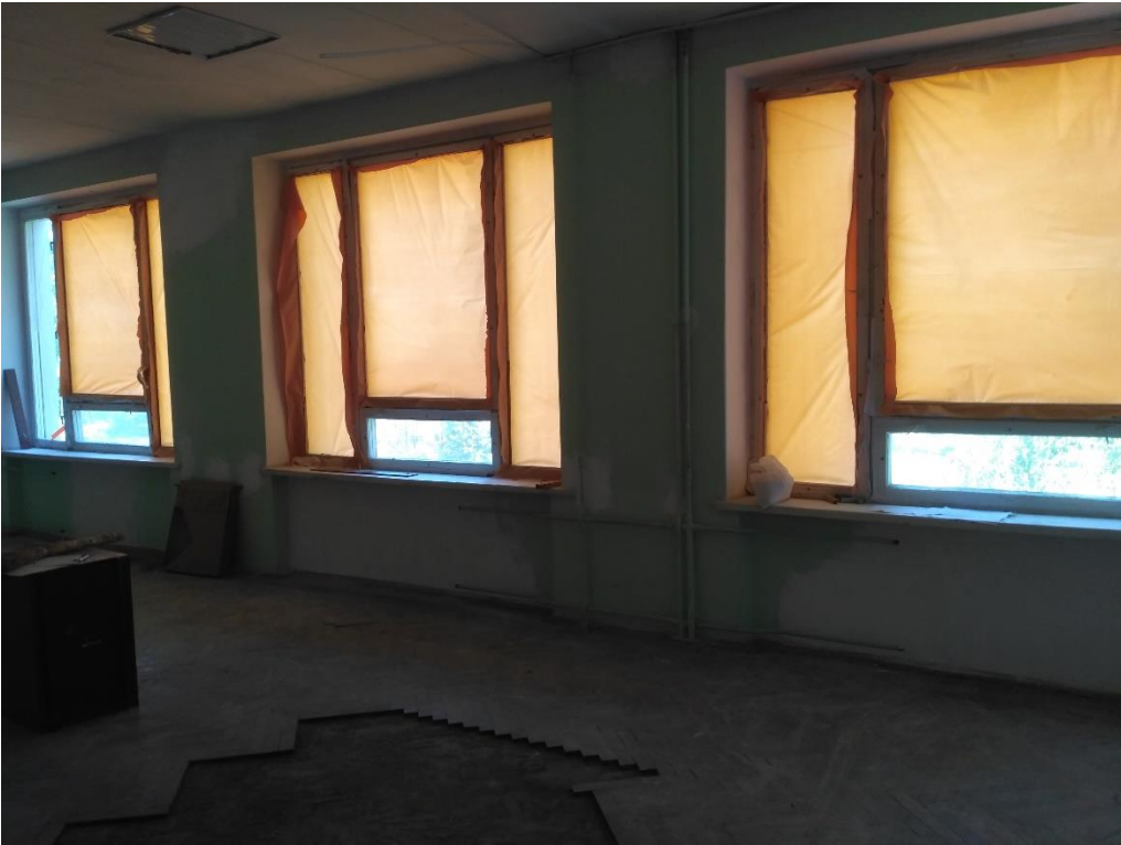
Фото 14,15. Пошкодження приміщення 208. Пошкодження дерев'яних вікон( розбите скло, пошкодження фурнітури, рам). Двері вибиті
