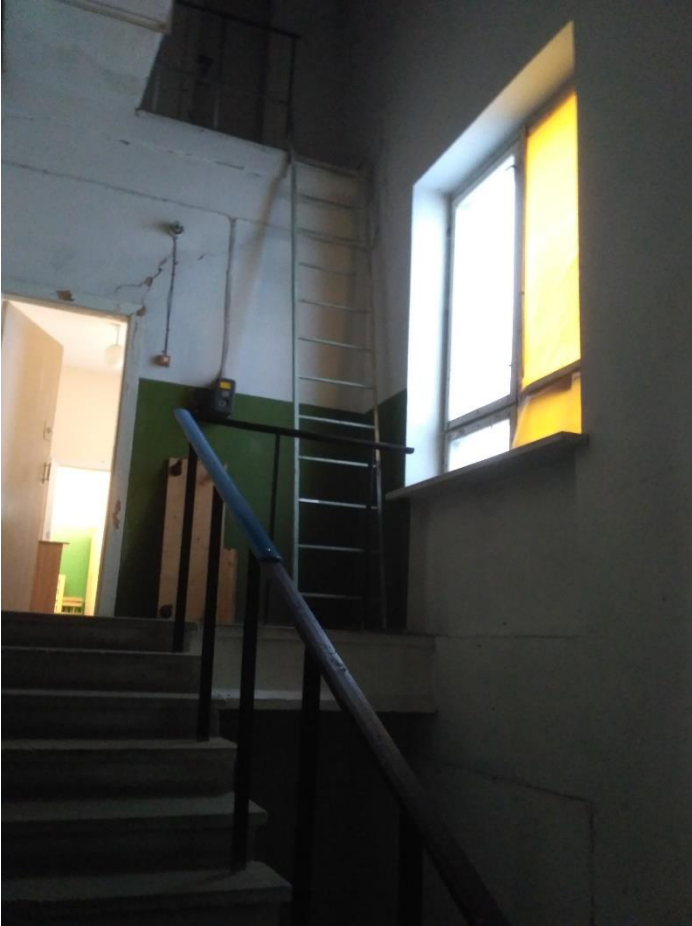
Фото 6,7,8. Пошкодження приміщення 276,277,280. Пошкодження дерев'яних вікон( розбите скло, пошкодження фурнітури, рам). Тріщини в кладці та штукатурці перегородок
