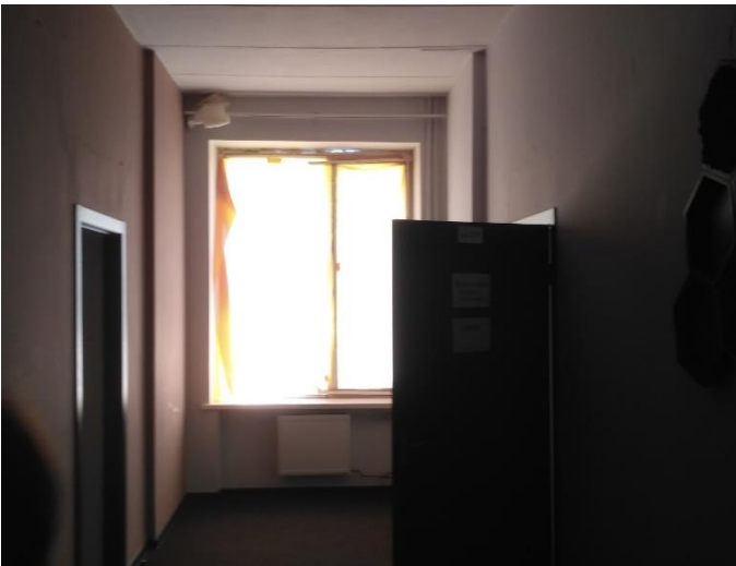
Фото 56. Пошкоджене вікно коридору поз. 256
