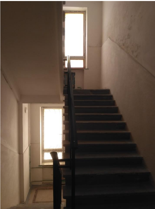
Фото 31. Пошкодження приміщення 226. Пошкоджені дерев'яні вікна( розбите скло, пошкодження фурнітури, рам).
