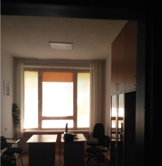
Фото 38. Пошкодження приміщення 231а. Пошкоджено дерев'яне вікно( розбите скло, пошкодження фурнітури, рам).
