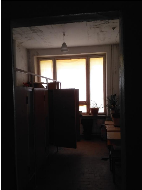
Фото 32-33. Пошкодження приміщення 229,230. Пошкоджені дерев'яні вікна( розбите скло, пошкодження фурнітури, рам). Тріщини та пошкодження штукатурки стін та стелі
