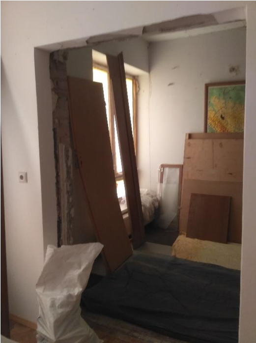
Фото 21-24. Пошкодження приміщення 215,214. Пошкодження м.п вікна( розбитий склопакет, пошкодження фурнітури, рам). Зруйнована стеля армстронг та двері в приміщенні 215
