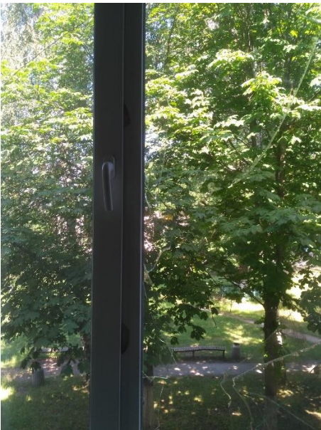
Фото 50. Фрагмент вікна приміщення 256. Пошкоджено м.п вікно( розбит склопакет, пошкодження фурнітури, рам).
