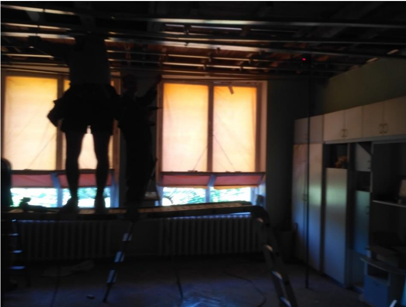
Фото 30. Пошкодження приміщення 218. Пошкоджені дерев'яні вікна( розбите скло, пошкодження фурнітури, рам). Пошкоджена підвісна стеля
