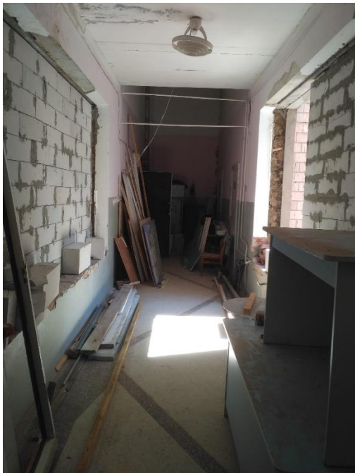
Фото 29. Пошкодження приміщення 224. Вибиті вікна.
