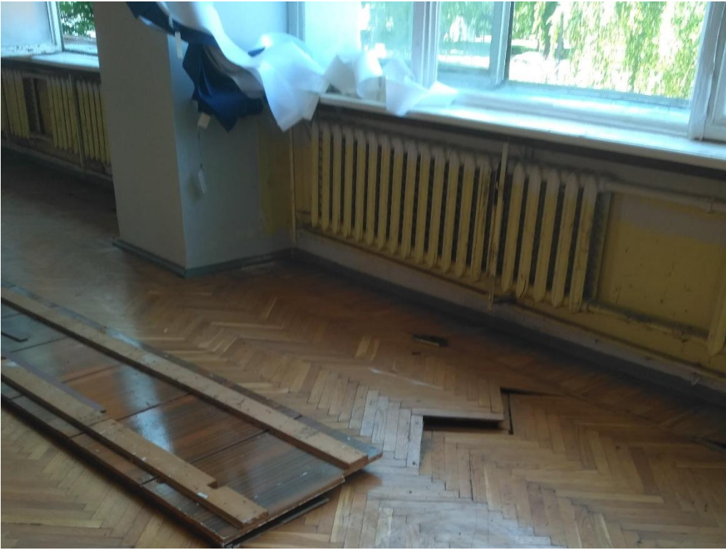
Фото 3,4,5. Пошкодження приміщення 275. Пошкодження вікон( розбите скло, пошкодження фурнітури, рам). Пошкодження паркету(вздуття) внаслідок витікання води з зруйнованих радіаторів
