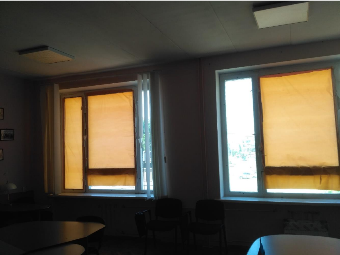
Фото 9,10. Пошкодження приміщення 205. Пошкодження дерев'яних вікон( розбите скло, пошкодження фурнітури, рам).
