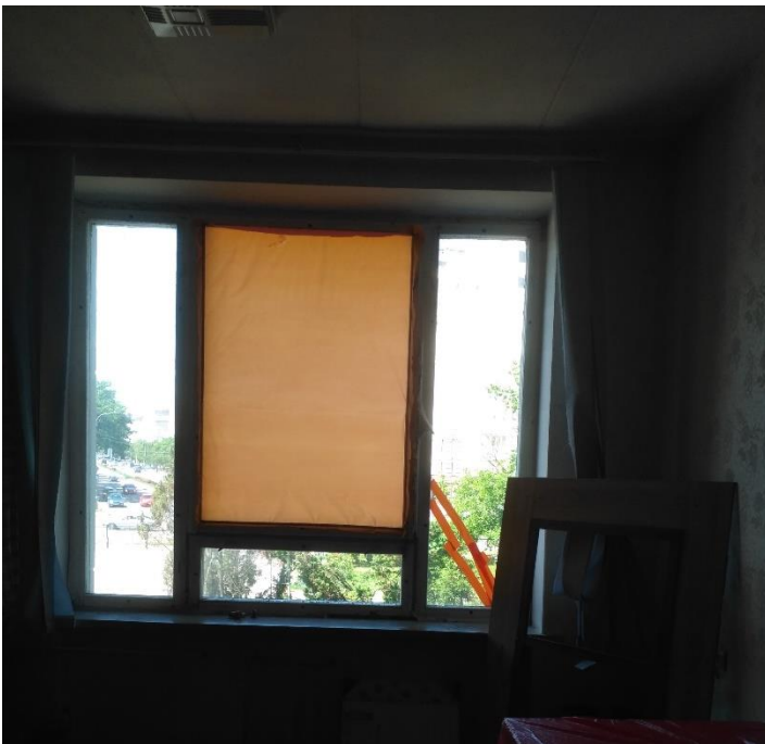
Фото 12. Пошкодження приміщення 207. Пошкодження дерев'яного вікна( розбите скло, пошкодження фурнітури, рам).
