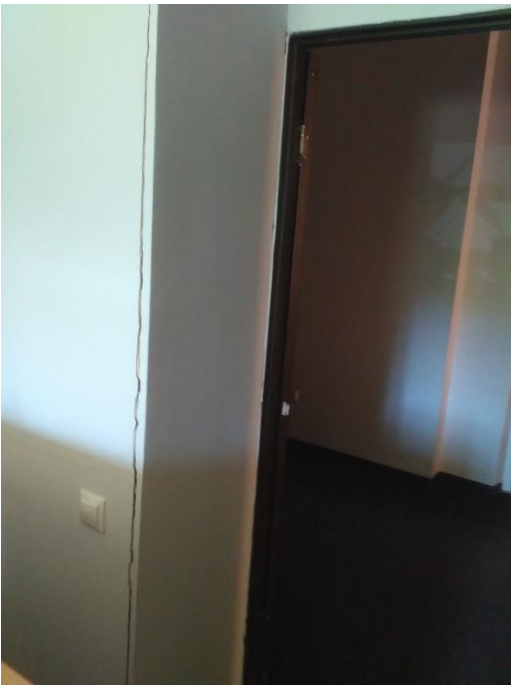
Фото 58. Вибиті двері приміщень 258,261,263,264-270, 244-248
