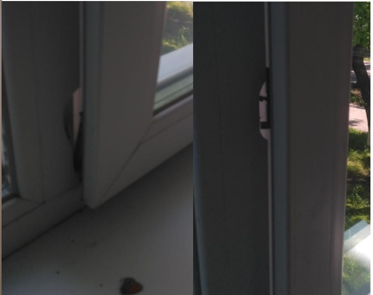
Фото 21-24. Пошкодження приміщення 215,214. Пошкодження м.п вікна( розбитий склопакет, пошкодження фурнітури, рам). Зруйнована стеля армстронг та двері в приміщенні 215
