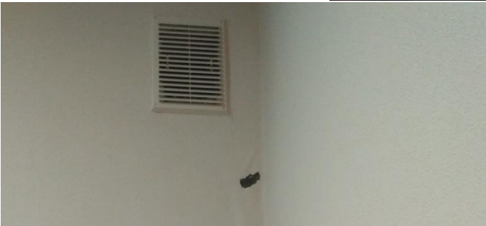
Фото 51-55. Пошкодження приміщень 249-252. Пошкоджено м.п вікна( розбиті склопакети, пошкодження фурнітури, рам). Вибиті двері . Одиичне осколкове ураження стіни, тріщини мурування перегородки та штукатурки
