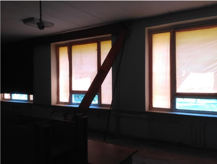
Фото 42. Пошкодження приміщення 235. Пошкоджено дерев'яні вікна( розбите скло, пошкодження фурнітури, рам).
