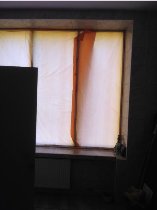
Фото 47. Пошкодження приміщення 242. Пошкоджено вікно( розбите скло, пошкодження фурнітури, рам).
