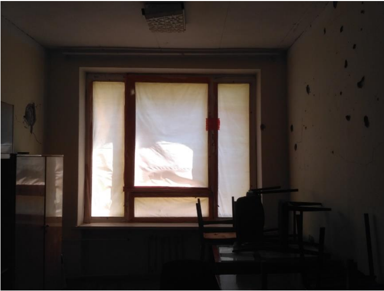
Фото 40. Пошкодження приміщення 233. Пошкоджено дерев'яне вікно( розбите скло, пошкодження фурнітури, рам). Осколкове ураження стін
