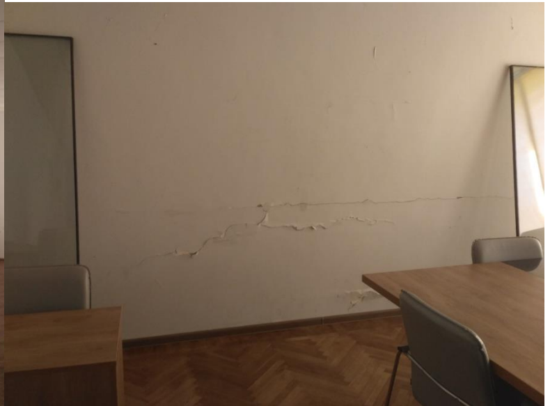
Фото 43-46. Пошкодження приміщення 237. Пошкоджено м.п вікна( розбиті склопакети, пошкодження фурнітури, рам). Тріщини в муруванні та штукатурці.
