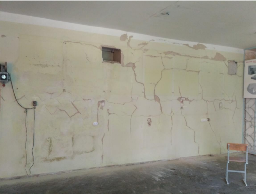
Фото 18,19. Пошкодження приміщення 211. Пошкодження вікон( розбите скло, пошкодження фурнітури, рам). Тріщини в кладці та штукатурці перегородок
