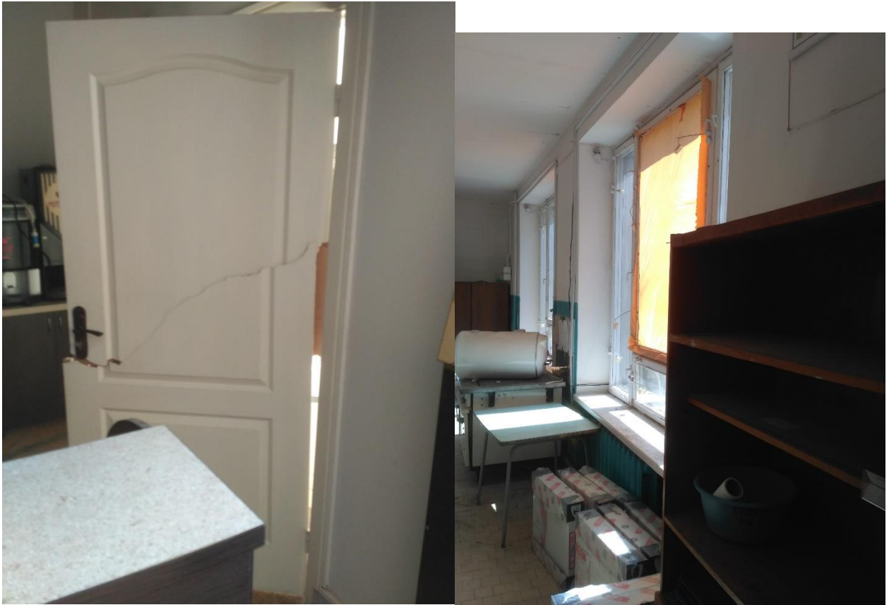
Фото 61. Пошкодження приміщення 272. Пошкоджені дерев'яні вікна( розбите скло, пошкодження фурнітури, рам).
