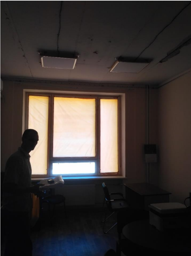
Фото 57. Пошкодження приміщення 261. Пошкоджено дерев'яне вікно( розбите скло, пошкодження фурнітури, рам). Вибиті двері .
