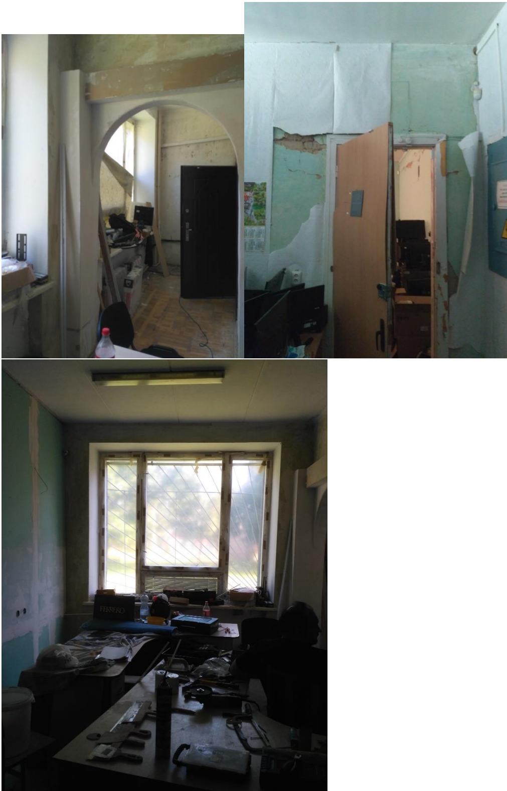
Фото 39-41 Пошкодження дерев'яних вікон приміщень 152-153( пошкодження фурнітури, розбите скло). Тріщини в штукатурці, двері розбиті
