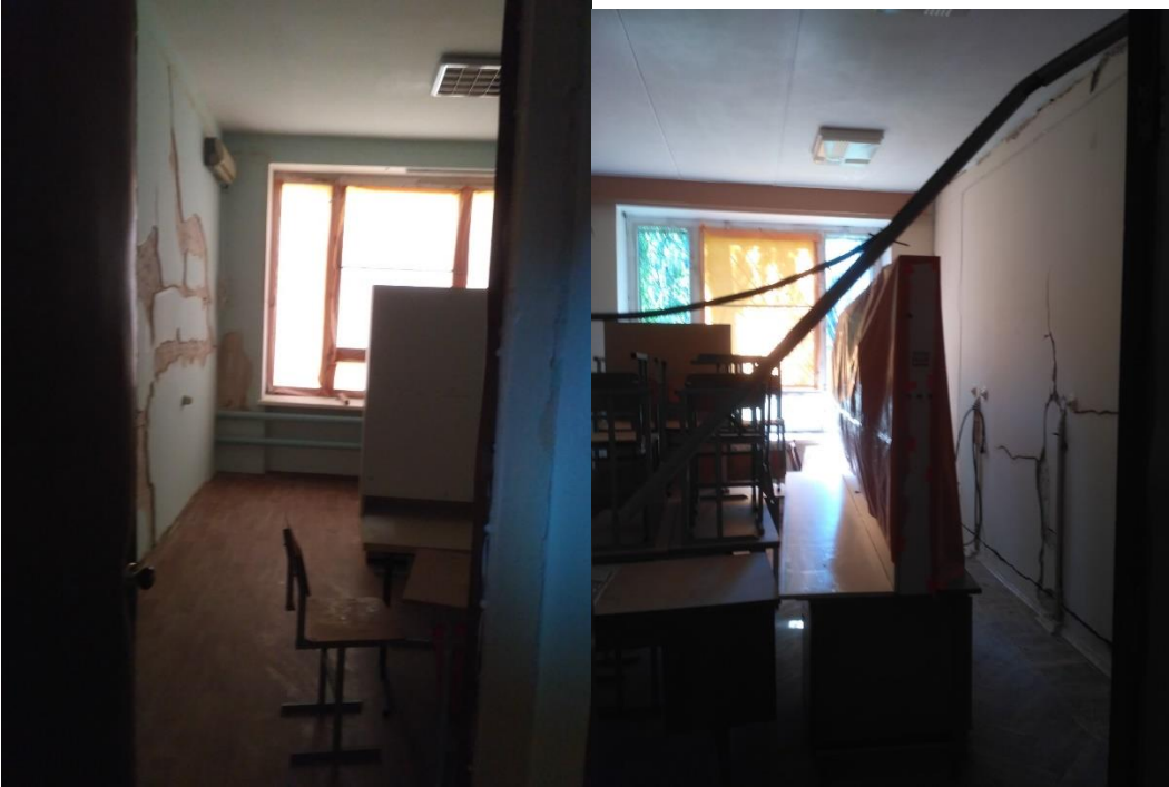
Фото 53-56 Пошкодження приміщень 173-175( пошкодження дерев'яних вікон фурнітури, розбите скло). Тріщини штукатурки
