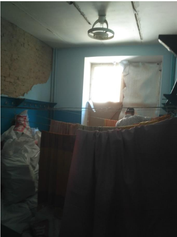
Фото 30 Пошкодження дерев'яного вікна приміщення 137( пошкодження фурнітури, розбите скло).
