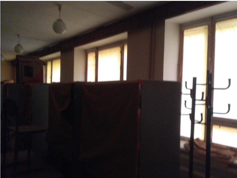
Фото 57 Пошкодження приміщень 172( пошкодження дерев'яних вікон фурнітури, розбите скло). Тріщини штукатурки. Штукатурка стелі осипалась
