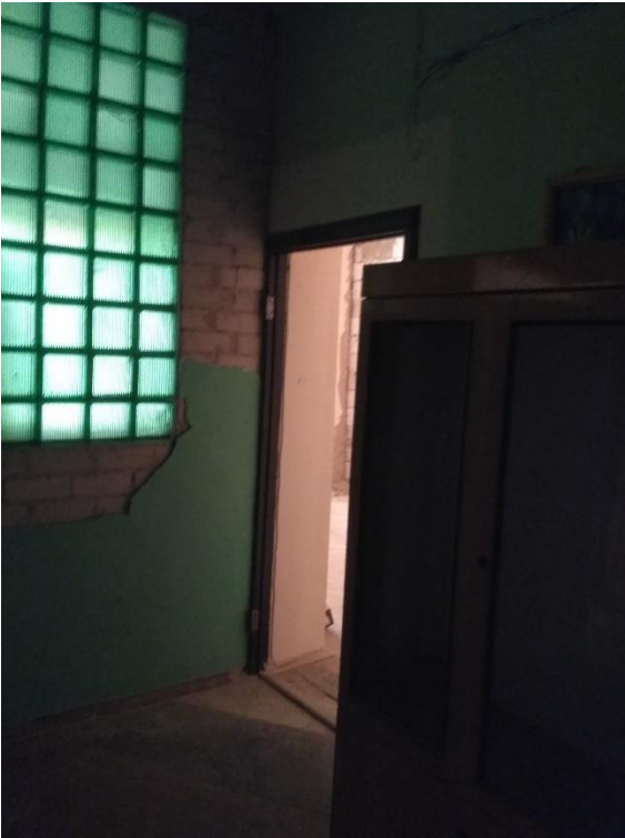
Фото 23-24 Пошкодження перегородки приміщення 119( осколкове пробиття склоблоків, штукатурка осипалась).
