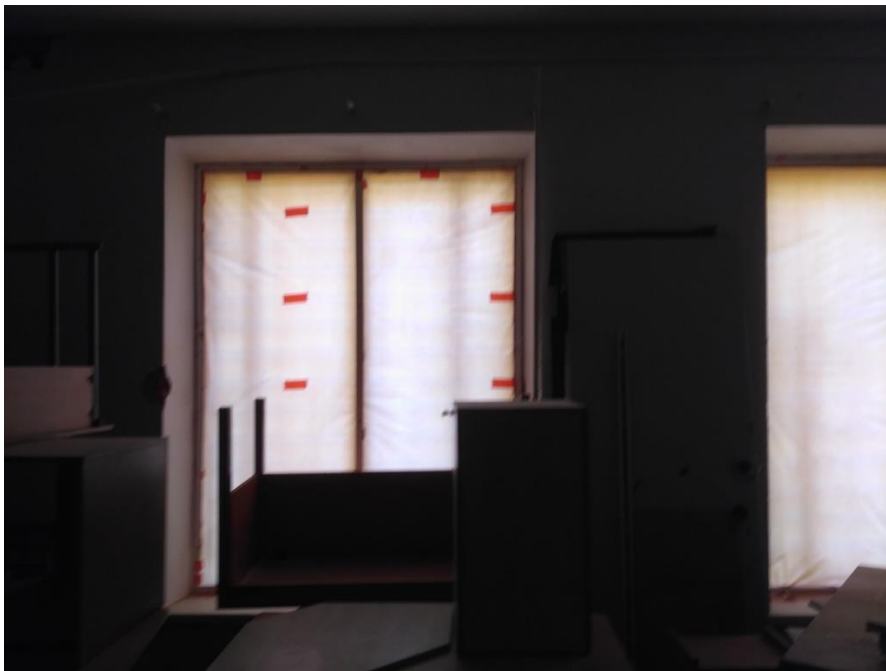
Фото 25 Пошкодження м.п вікон приміщення 118( пошкодження фурнітури, сколи рам, розбиті склопакети).
