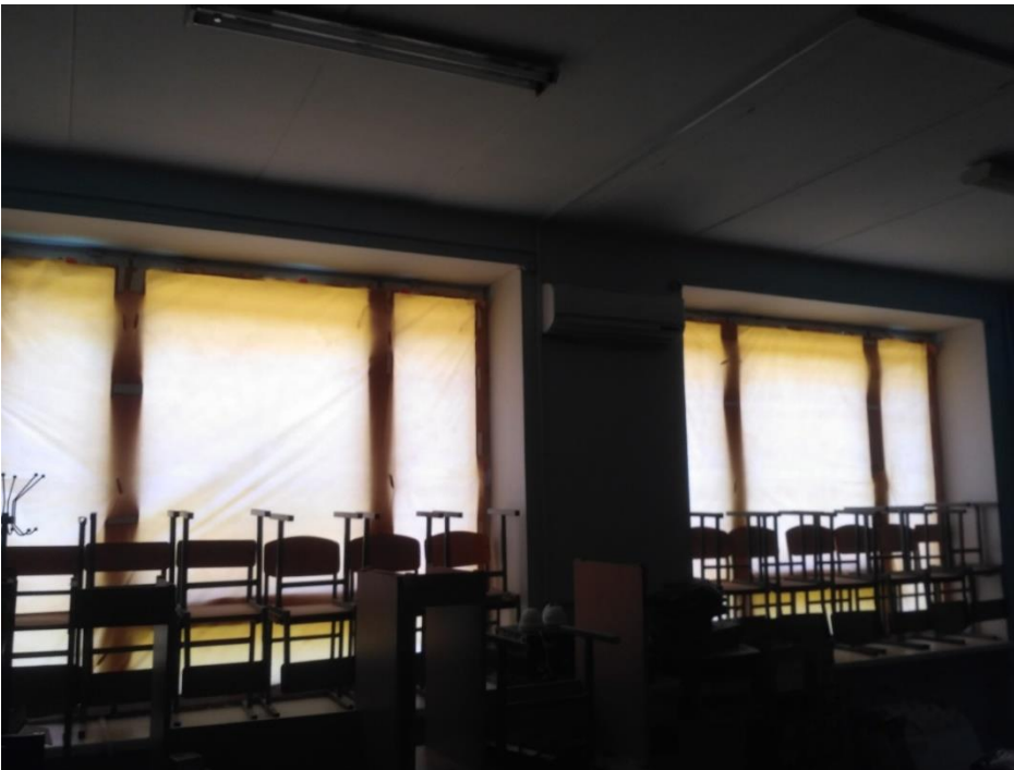
Фото 38 Пошкодження дерев'яних вікон приміщень 151( пошкодження фурнітури, розбите скло).
