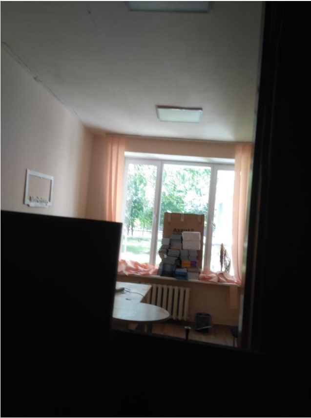
Фото 16 Пошкодження м.п вікна приміщення 115( пошкодження фурнітури, сколи рам).
