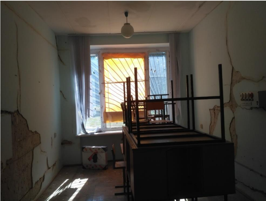
Фото 50 Пошкодження приміщень 178( пошкодження дерев'яного вікна фурнітури, розбите скло). Тріщини штукатурки
