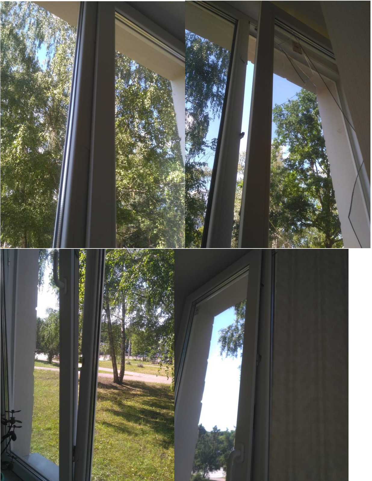
Фото 10-13 Пошкодження м.п вікон приміщень 107-111( пошкодження фурнітури, сколи рам).
