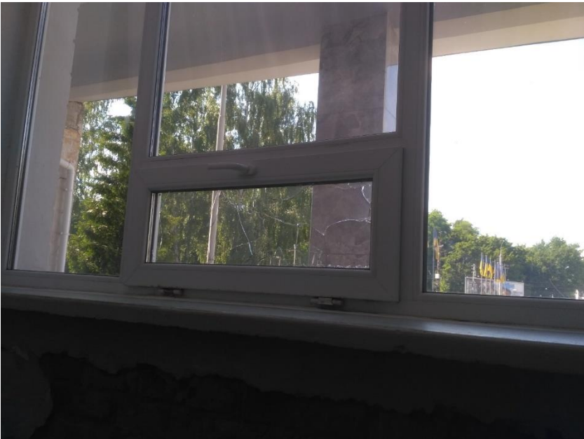
Фото 43 Пошкодження м.п вікон приміщень 189(розбитий склопакет потребує заміни, рама та фурнітура ціла). Друге вікно приміщення м.п ціле
