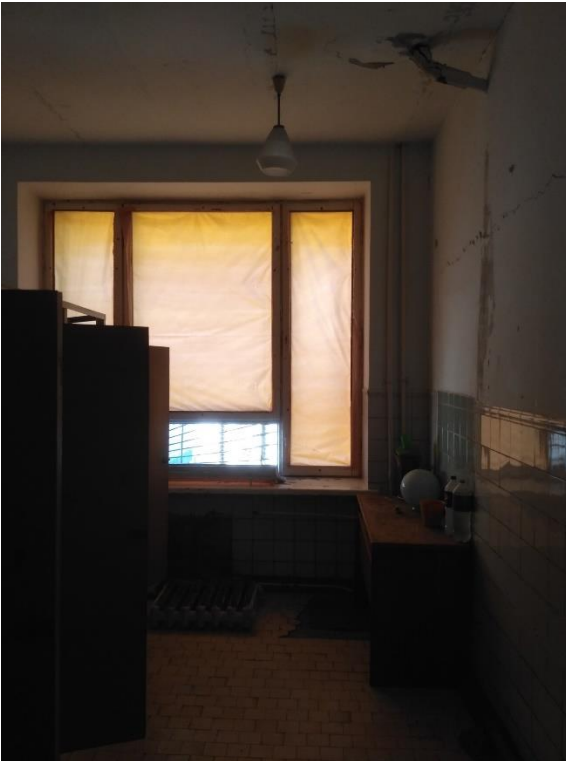
Фото 31-32 Пошкодження дерев'яних вікон приміщення 140,143( пошкодження фурнітури, розбите скло). Тріщини штукатурки, плитка осипається
