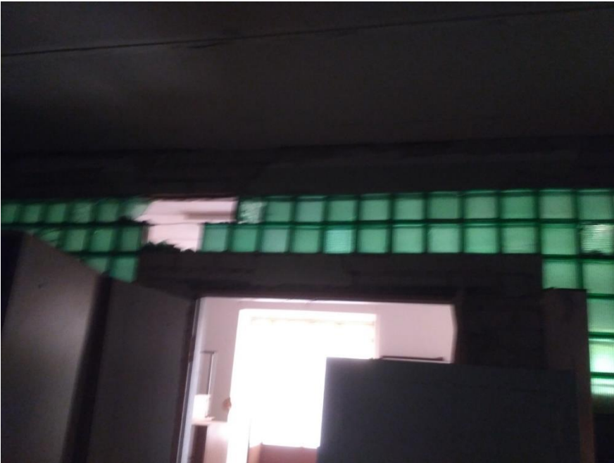
Фото22 Пошкодження м.п вікна приміщення 117( пошкодження фурнітури, сколи рам).
