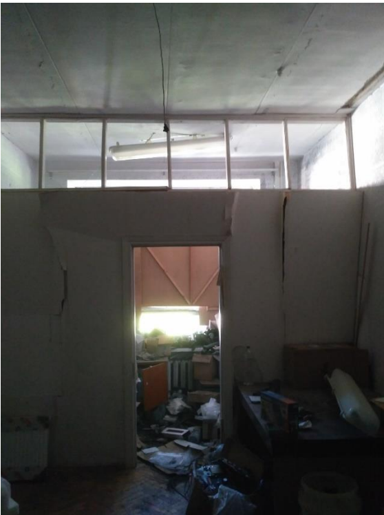
Фото 33 Пошкодження дерев'яного вікна приміщення 150( пошкодження фурнітури, розбите скло). Розбита перегородка
