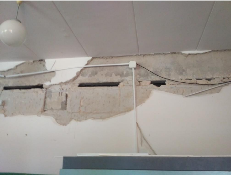
Фото 51-52 Пошкодження приміщень 177( пошкодження дерев'яних вікон фурнітури, розбите скло). Тріщини штукатурки
