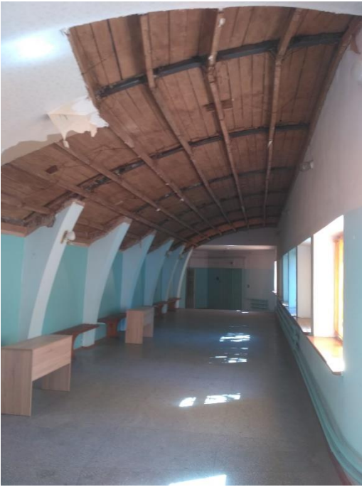
Фото 57 Пошкодження приміщень 172( пошкодження дерев'яних вікон фурнітури, розбите скло). Тріщини штукатурки. Штукатурка стелі осипалась
