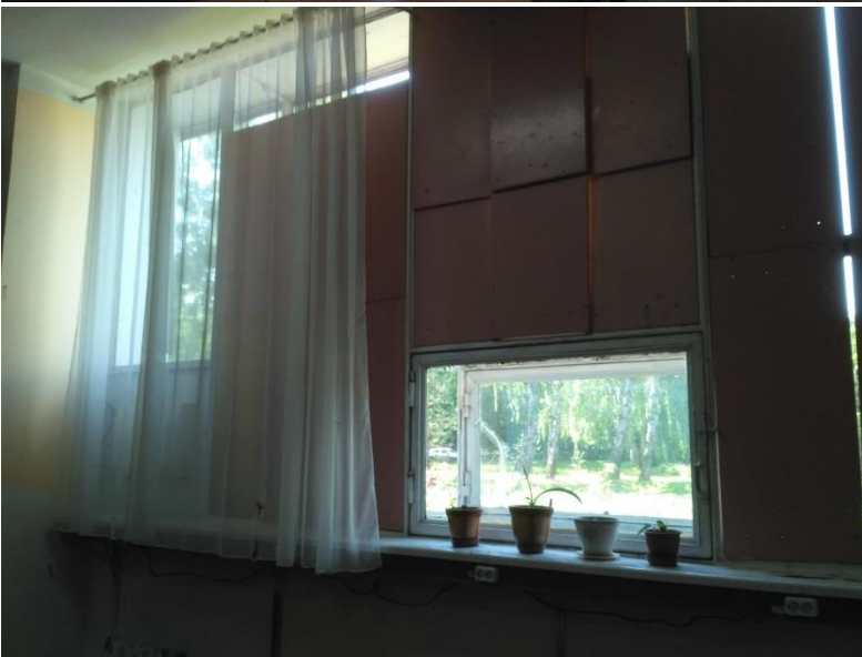
Фото 45-46 Пошкодження дерев'яних вікон приміщень 192( пошкодження фурнітури, розбите скло).
