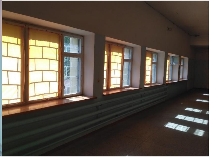
Фото 57 Пошкодження приміщень 172( пошкодження дерев'яних вікон фурнітури, розбите скло). Тріщини штукатурки. Штукатурка стелі осипалась
