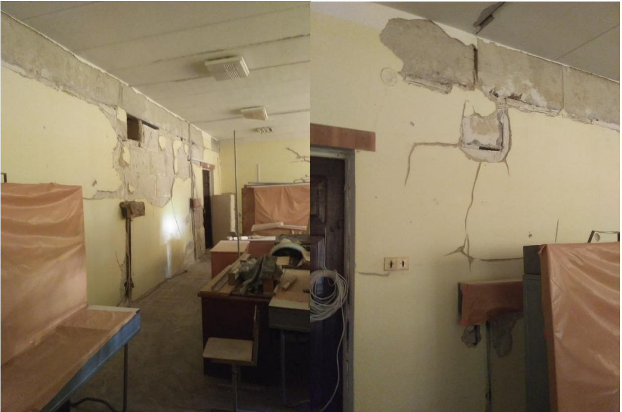
Фото 60-64 Пошкодження приміщень 163-161( пошкодження дерев'яних вікон фурнітури, розбите скло). Тріщини штукатурки
