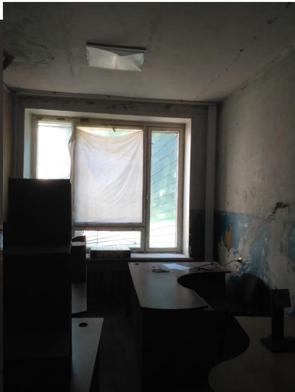
Фото 31-32 Пошкодження дерев'яних вікон приміщення 140,143( пошкодження фурнітури, розбите скло). Тріщини штукатурки, плитка осипається
