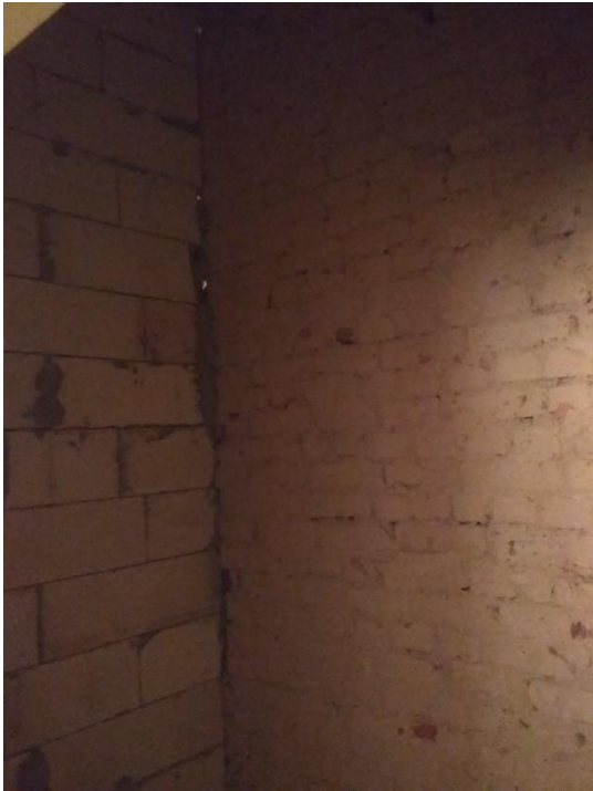
Фото 26-28 Пошкодження приміщень 220-221(Розбиття вікон м.п пошкодження фурнітури, сколи рам, розбиті склопакети). Штукатурка осипалась
