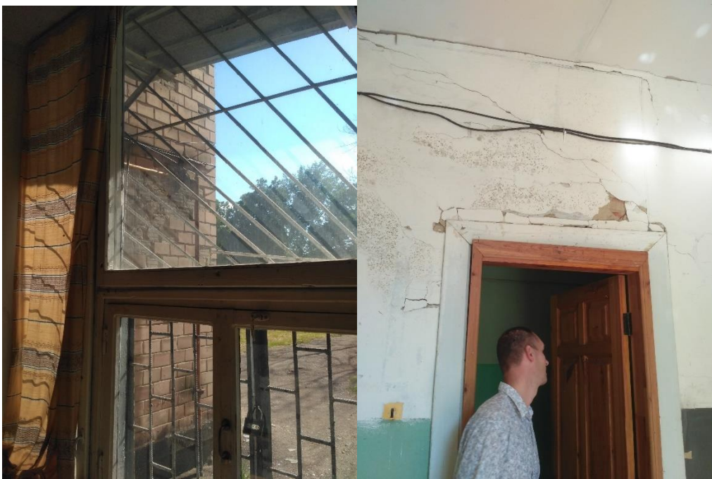
Фото 47-48 Пошкодження приміщень 180-182( пошкодження дерев'яних вікон фурнітури, розбите скло). Тріщини штукатурки
