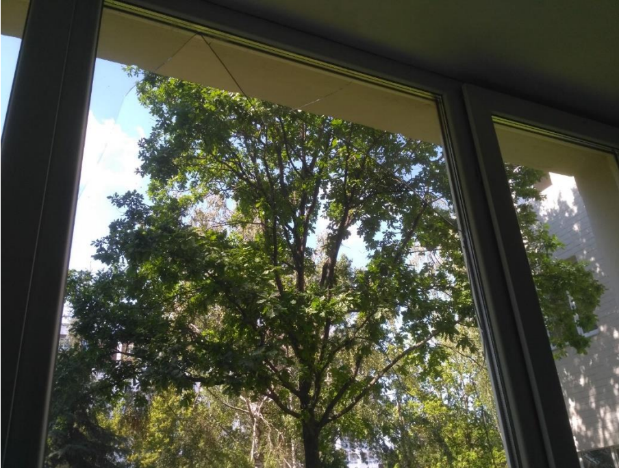
Фото 14-15 Пошкодження м.п вікон приміщення 112( пошкодження фурнітури, сколи рам, розбитий склопакет).
