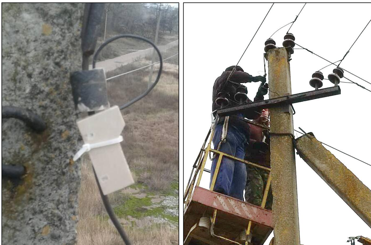
Рис. 4.10. Фото встановленого опитну експлуатацію в електричні мережі
