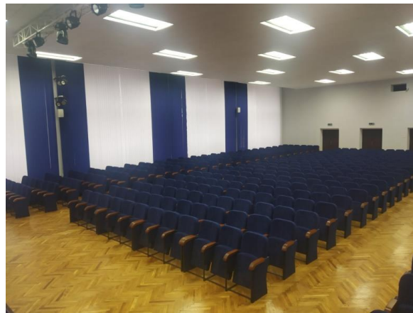
Рис 8.3 – Поточний ремонт актової зали
