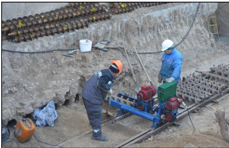
Рис. 1 – Виконання бурових робіт на об'єкті
