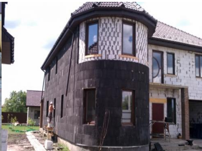
Рис.2. Утеплення фасадів
