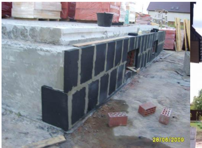
Рис.1. Утеплення фундаменту
