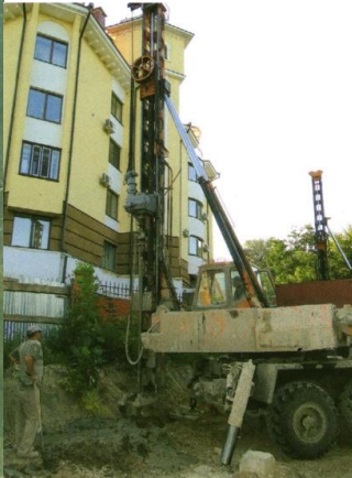
Рис. 3 - Бур (ріжуча частина)
