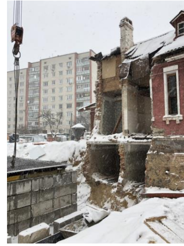
Рис. 3 – Дослідження конструкцій будівель під час їх демонтажу
